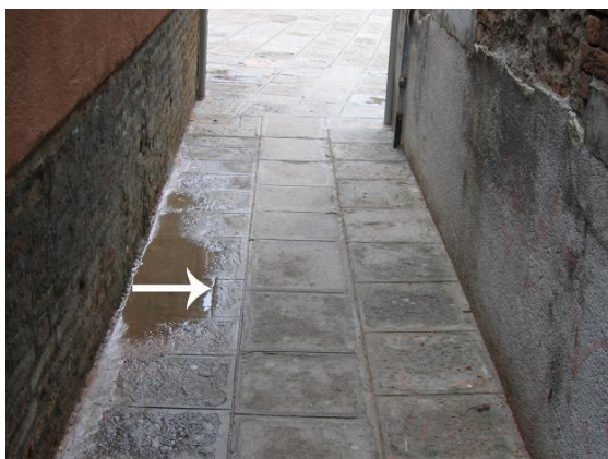
Avvallamento dalla larghezza > 1,2 m ma grado di ostruzione relativamente basso (25 -50 %).
