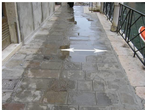
Avvallamento ridotto ( L < 1,2 m) dal grado di ostruzione basso (0 - 25%)
