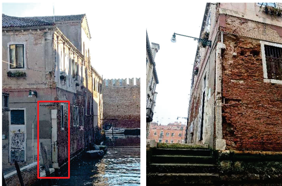
Piedritto lapideo di cantonale in condizioni di dissesto
