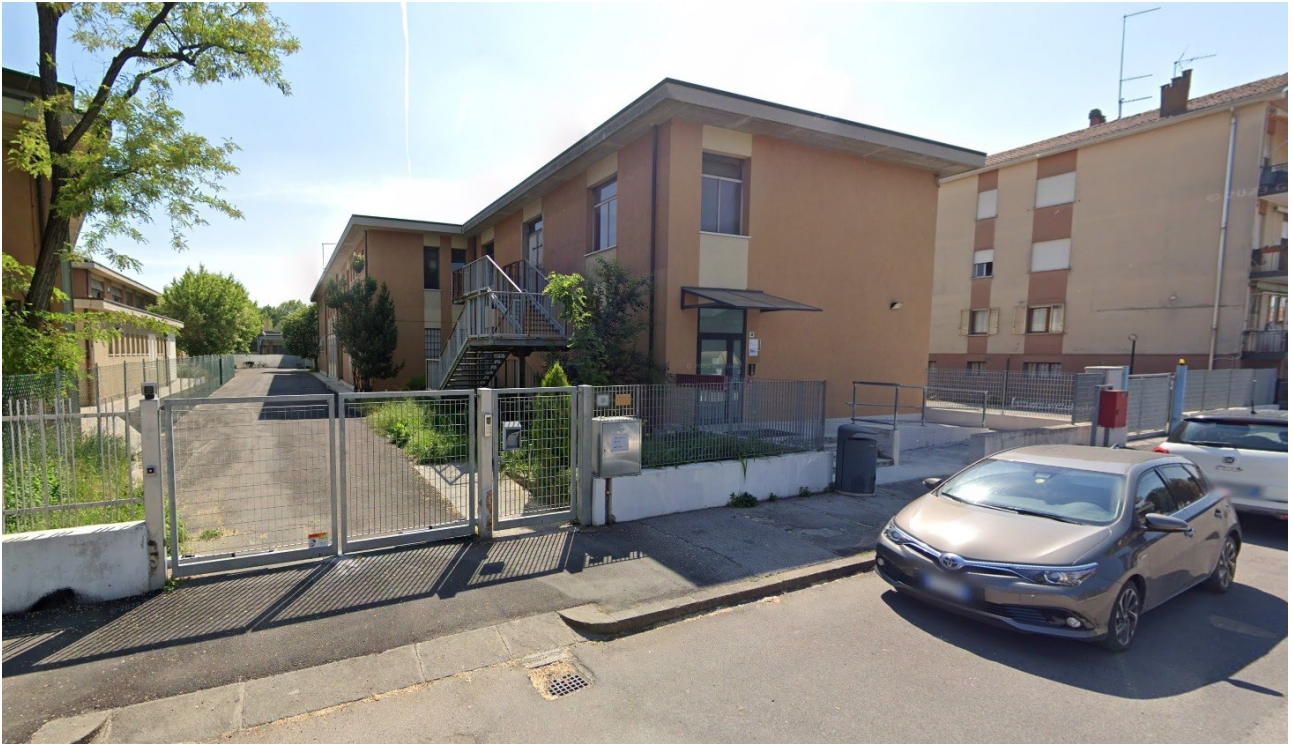
Accesso carraio da via Mameli
