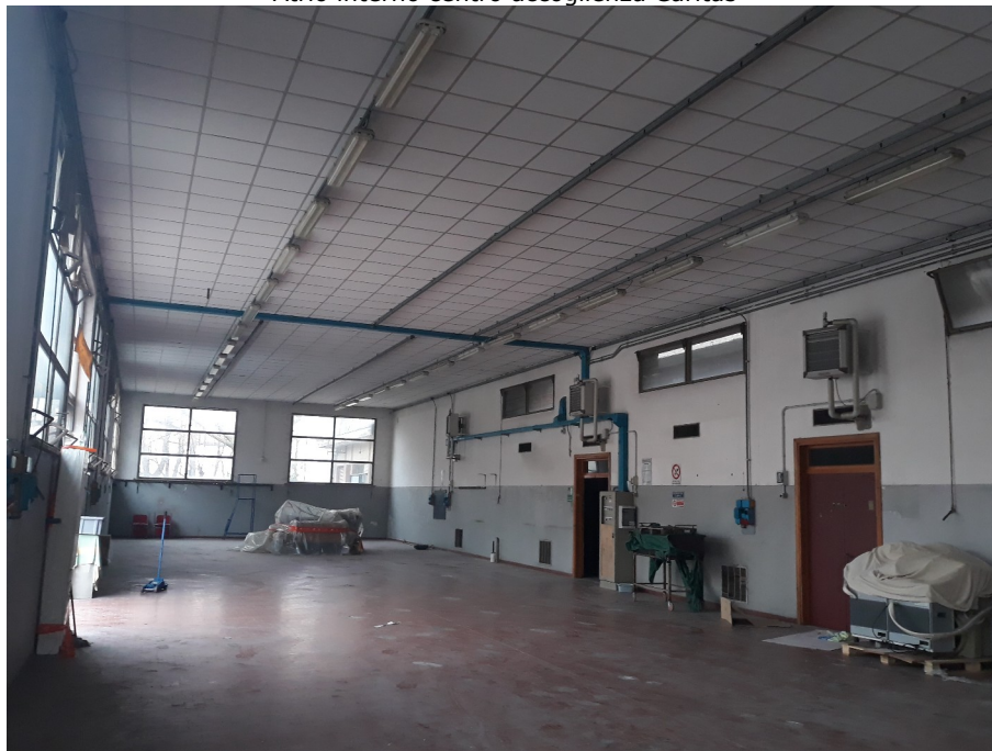
Magazzino Protezione Civile Comune di Venezia
