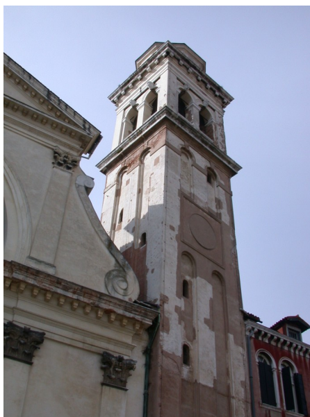
Foto 1 – Campanile di San Trovaso
