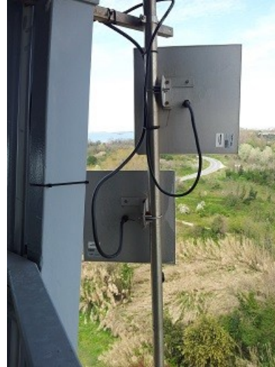
Foto 2 - Quadro Apparati Radio e Router
