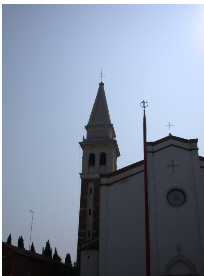
Foto 1 – Campanile di Malamocco
