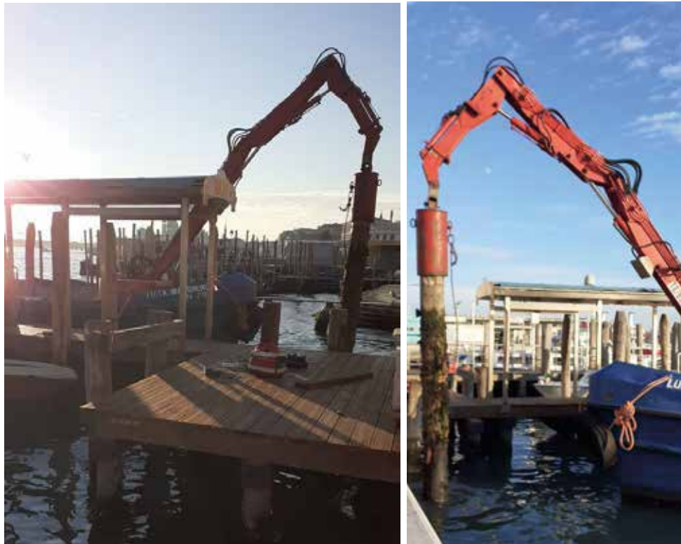
Infissione di pali di ormeggio per manutenzione di una stazione taxi.
