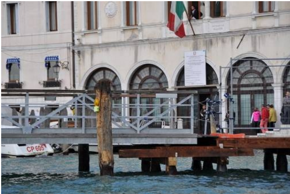
Particolare della testata del ponte lato S.Marco (Venice Marathon)
