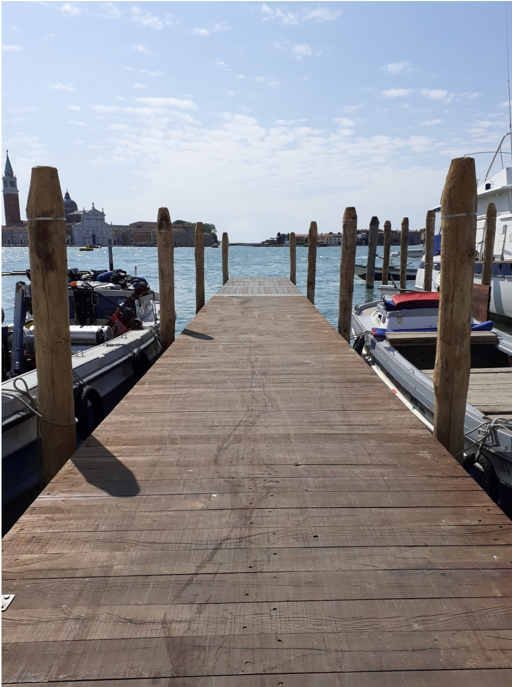
Veduta complessiva del pontile 111 - PONTILE MERCI MOLO SAN MARCO (LATO STAZ. TAXI N. 8)
