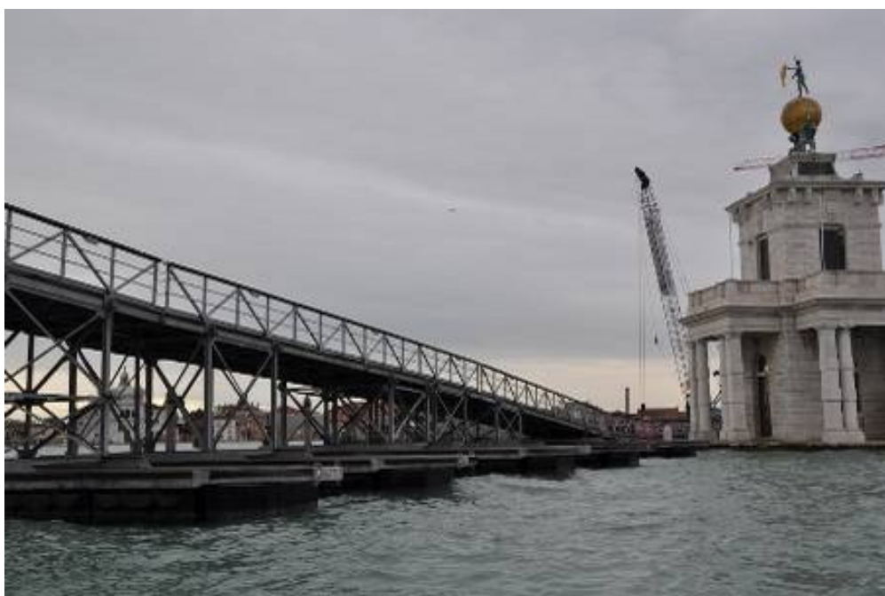
Particolare della testata del ponte punta della Dogana (Venice Marathon)
