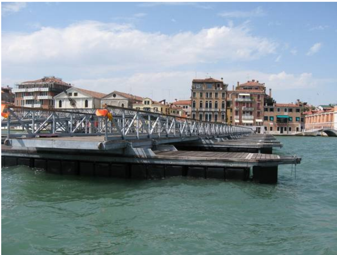
Assemblaggio moduli del ponte di attraversamento del Canal Grande
