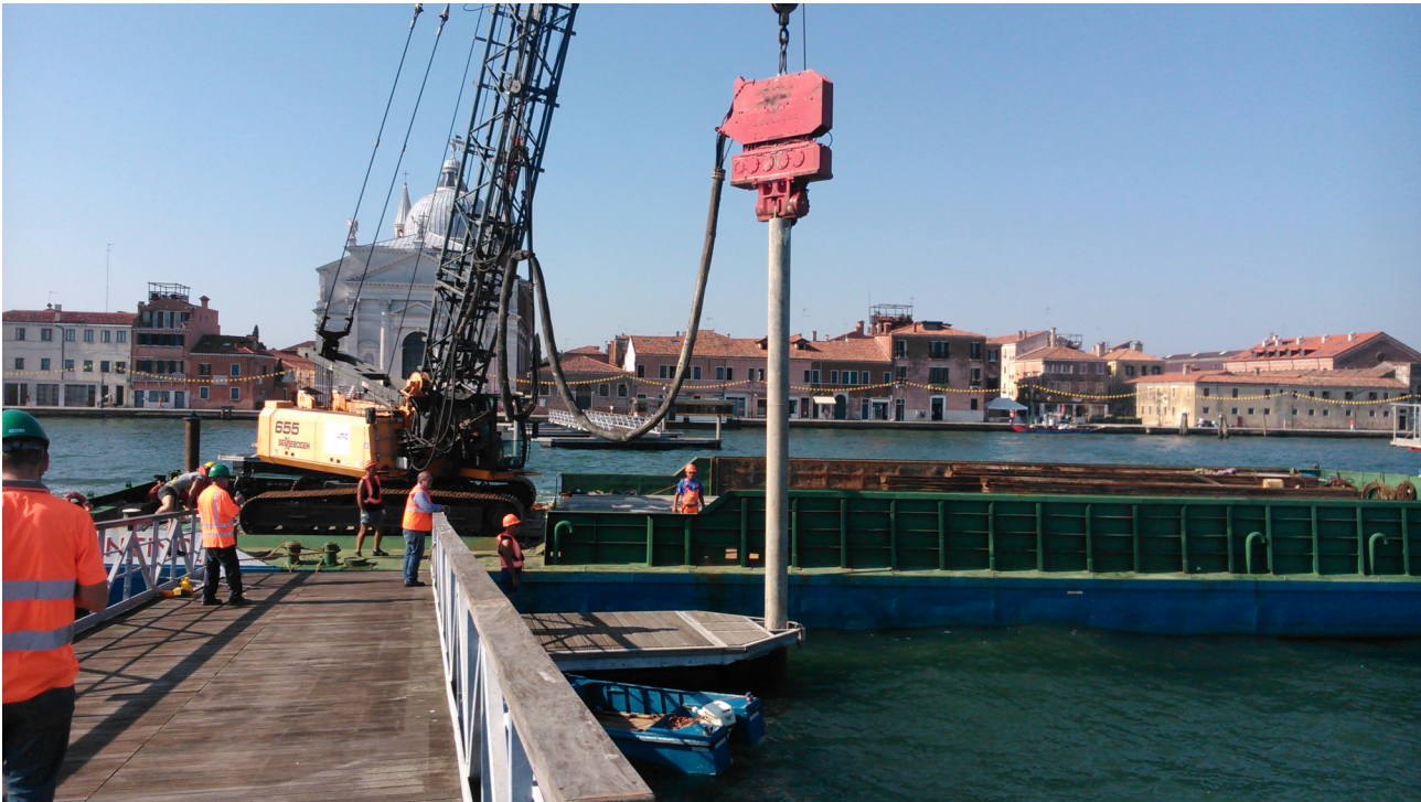
Infissione pali di ormeggio
