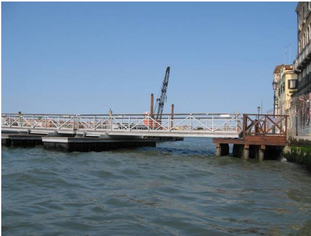
Testata del ponte
