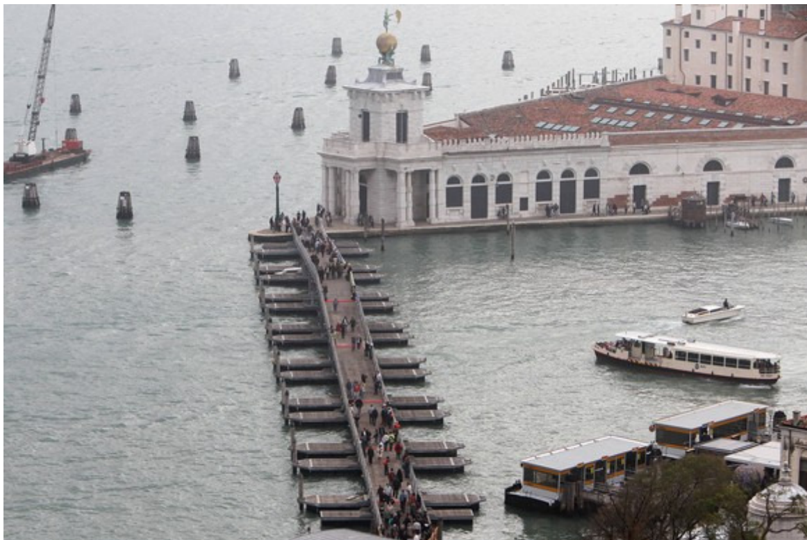
Veduta complessiva ponte Venice Marathon.
