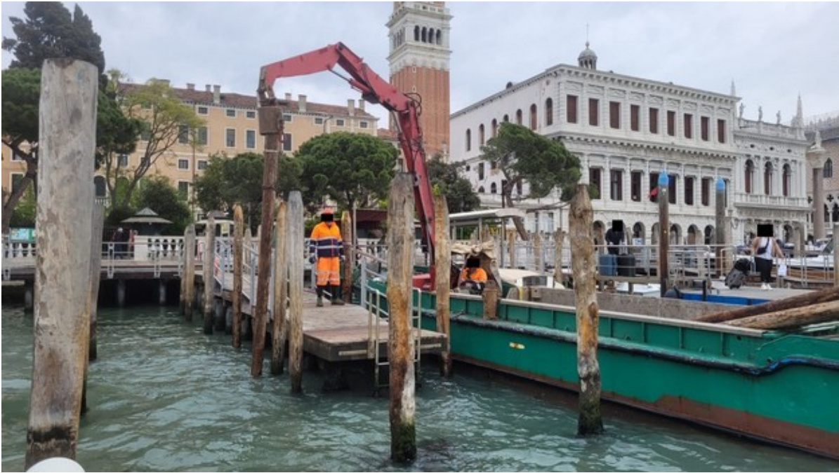
Figura 1 – Realizzazione di pontile.
