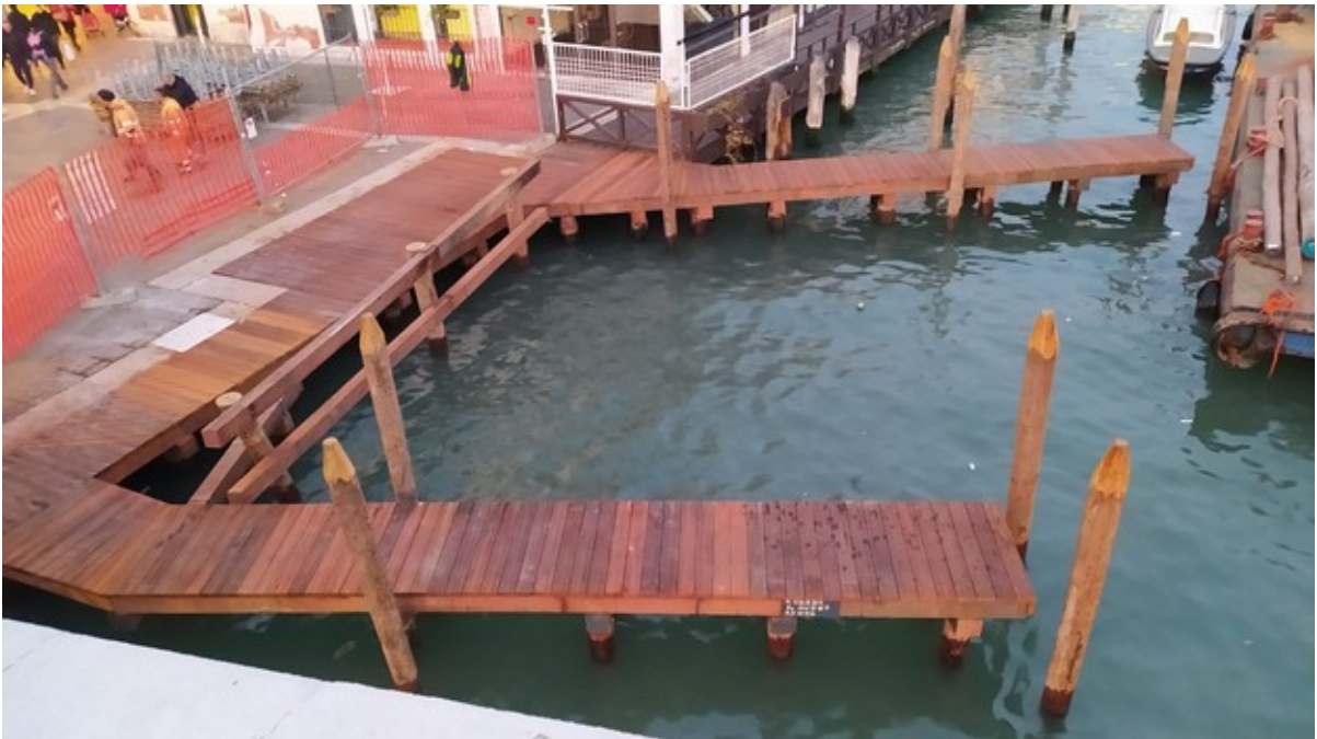
Figura 2 – Realizzazione di due pontili merci.
