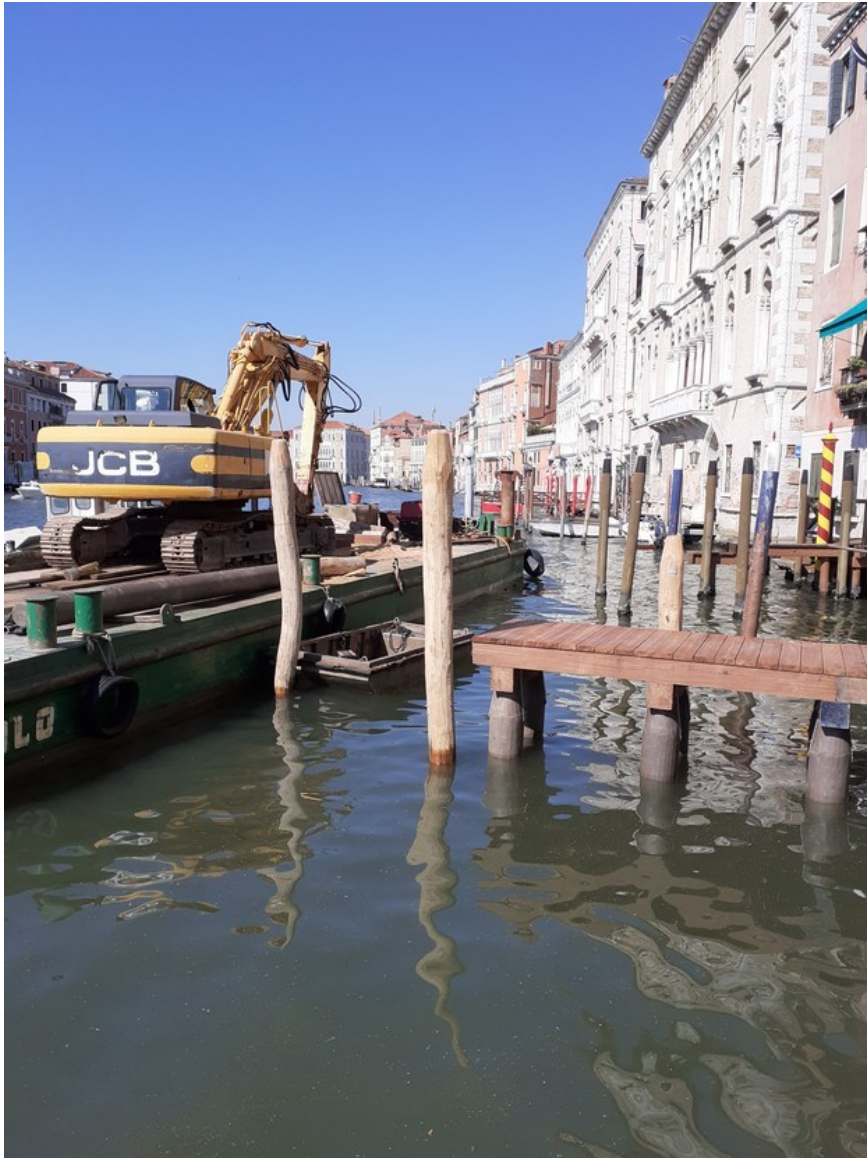
Figura 3- Realizzazione di un pontile.
