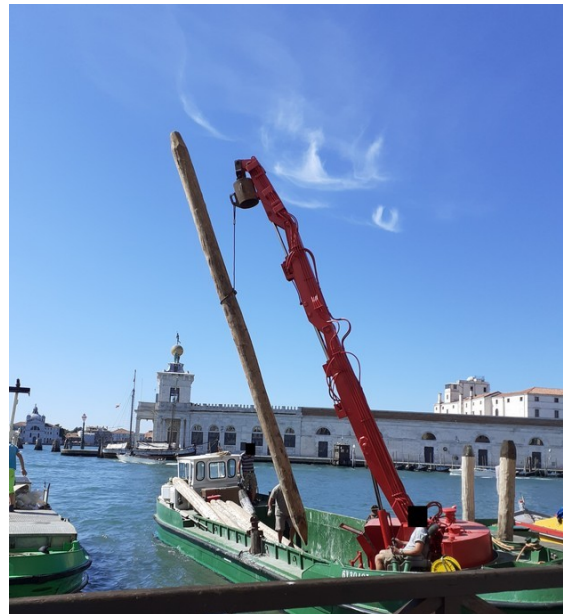
Figura 4 - Infissione di pali di ormeggio.
