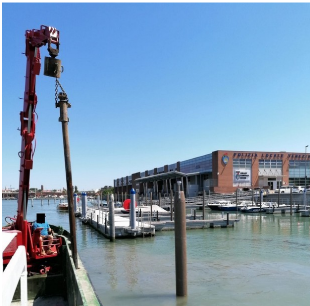
Figura 4 - Infissione di pali di ormeggio.
