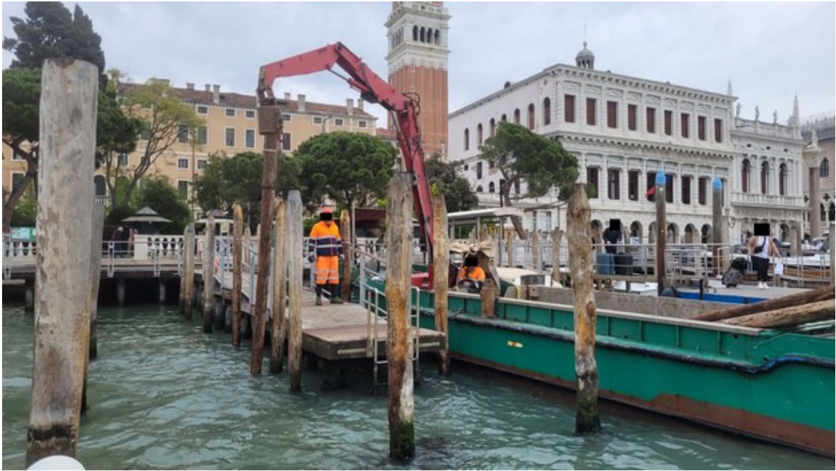
Figura 1 – Realizzazione di pontile.
