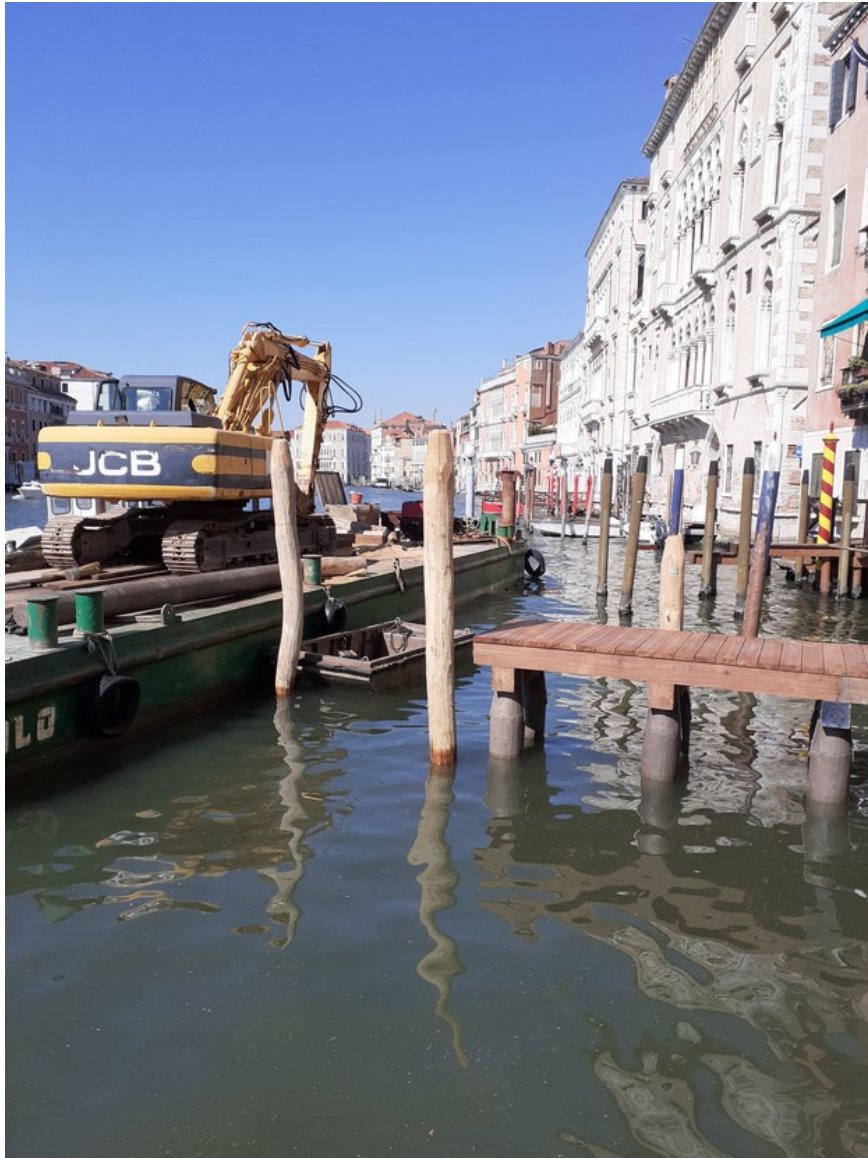
Figura 3- Realizzazione di un pontile.
