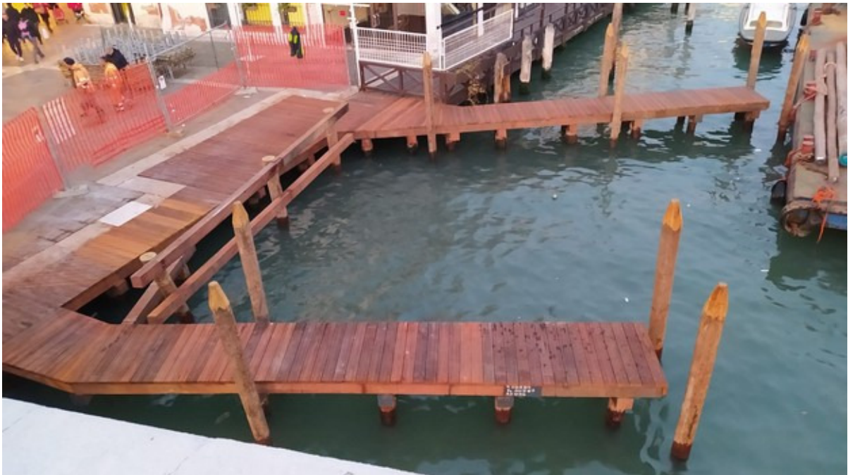
Figura 2 – Realizzazione di due pontili merci.
