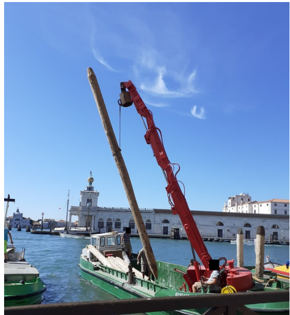
Figura 4 - Infissione di pali di ormeggio.
