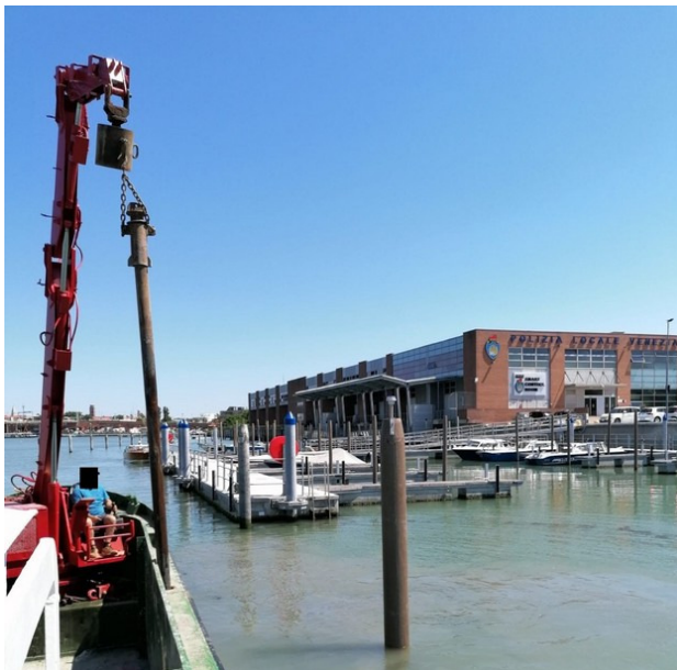
Figura 4 - Infissione di pali di ormeggio.
