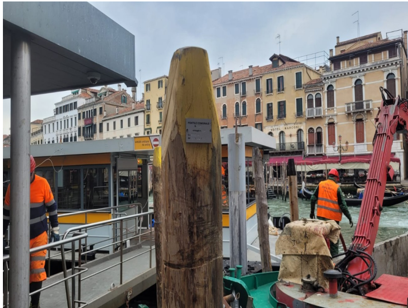
Infissione di pali di ormeggio con targhetta identificativa presso Stazione Taxi N. 092 - STAZIONE TAXI N. 6 - RIALTO-CERVA
