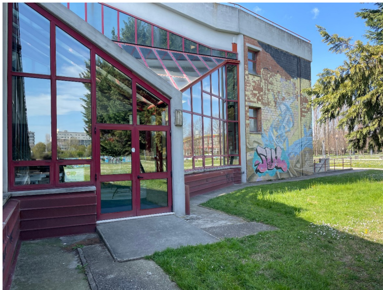
Attuali serramenti dell'edificio polifunzionale
