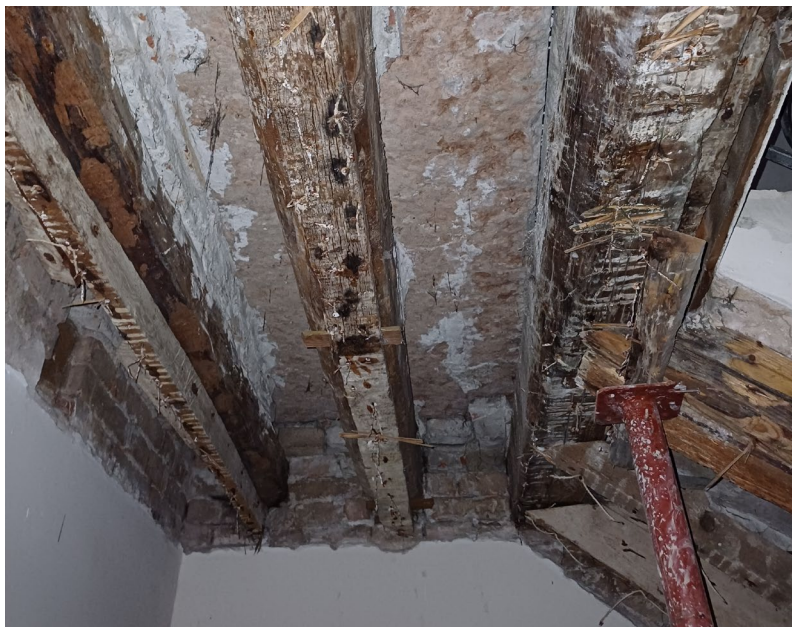
Struttura del pianerottolo del secondo piano
