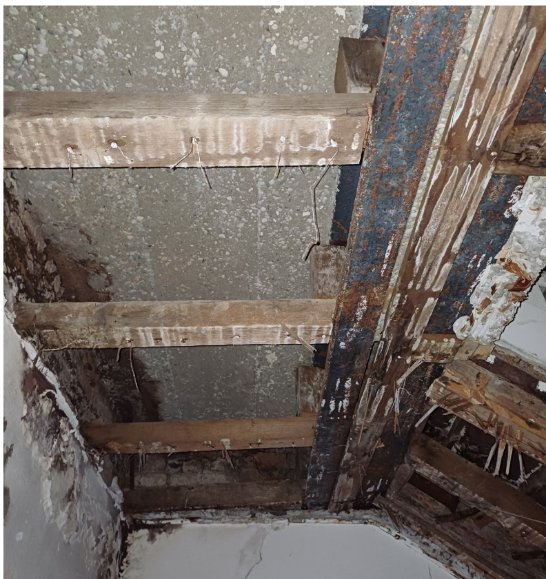
Struttura del pianerottolo del terzo piano con presenza di elementi metallici e calcestruzzo forse a seguito di una sopraelevazione della scala
