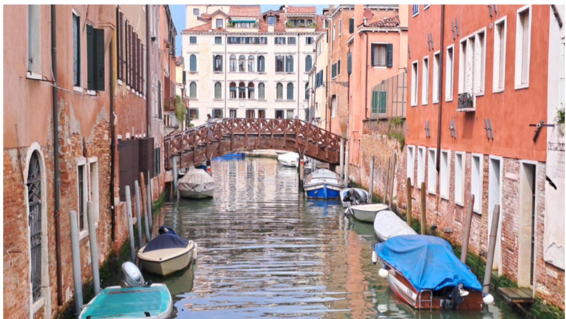
Area oggetto d'intervento - Il ponte visto da Sud
