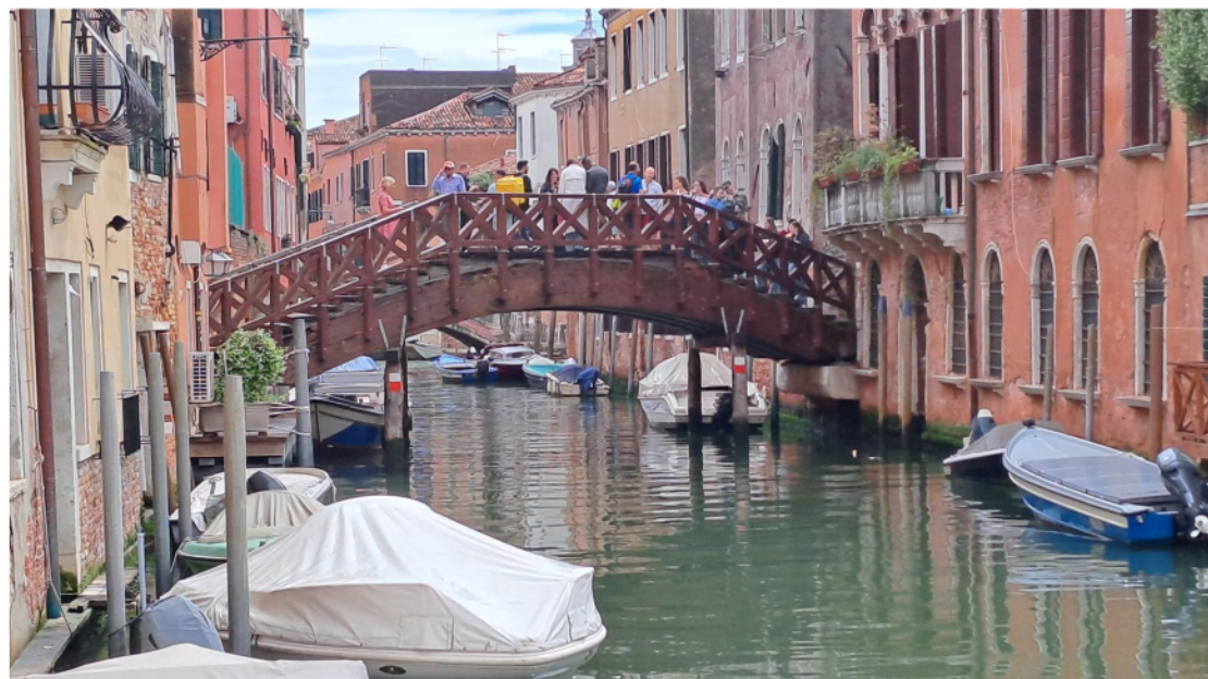
Fig. 3.2.1 - Area oggetto d'intervento - Il ponte visto da Nord
