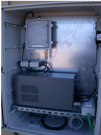
Foto 4 – Quadro Apparatı Radio e UPS
