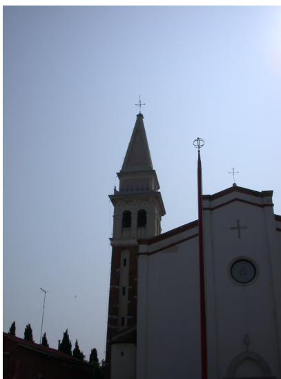
Foto 1 – Campanile di Malamocco
