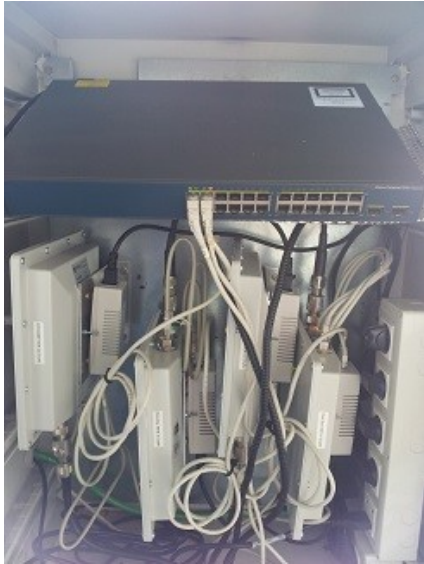
Foto 2 - Quadro Apparati Radio e Router
