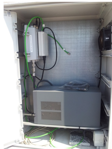
Foto 2 – Altoparlanti all'esterno e Antenna Foto 3 – Quadro Apparati Radio e Wi-Fi
