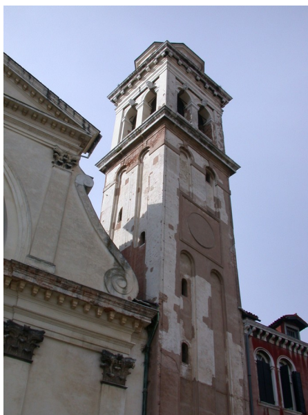
Foto 1 – Campanile di San Trovaso
