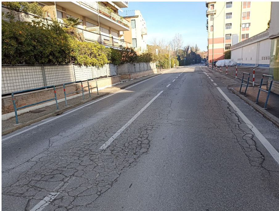
Fig. 4.4: Fotografia dello stato di fatto del Lungomare Marconi
