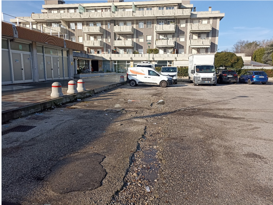
Fig. 4.1: Fotografia dello stato di fatto in Via Giusto Fuga
