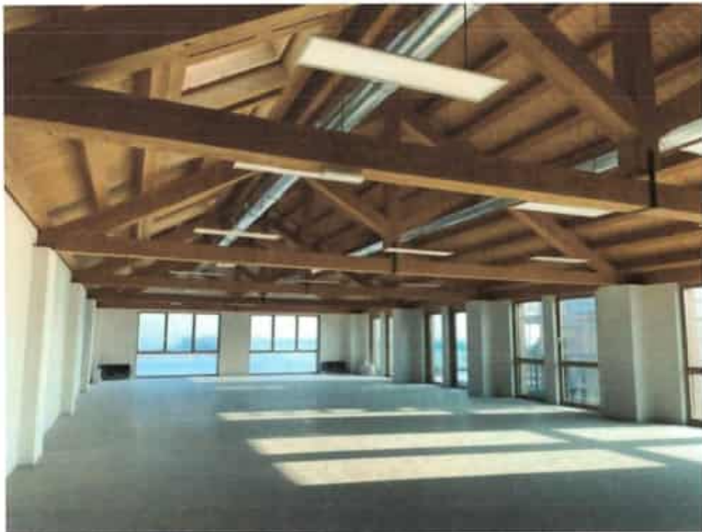
Foto n.1 e 2 – fasi di realizzazione delle finiture del nuovo fabbricato (installazione ringhiera e fancoil)
