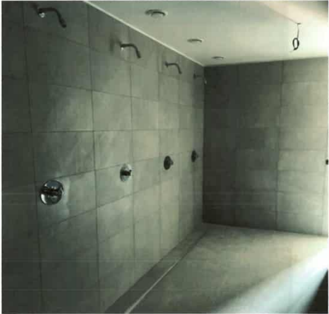
Foto n.3 – fasi di realizzazione delle docce nei servizi igienici
