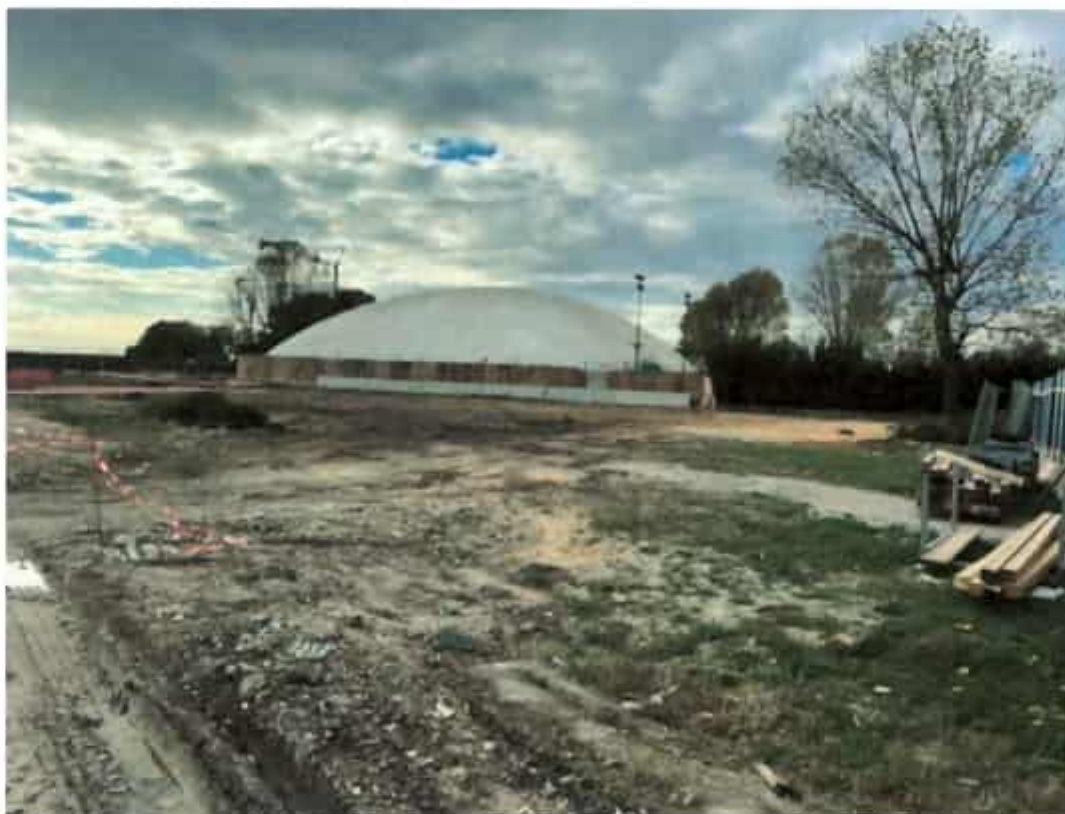
Foto n.1, 2 – veduta aree esterne
