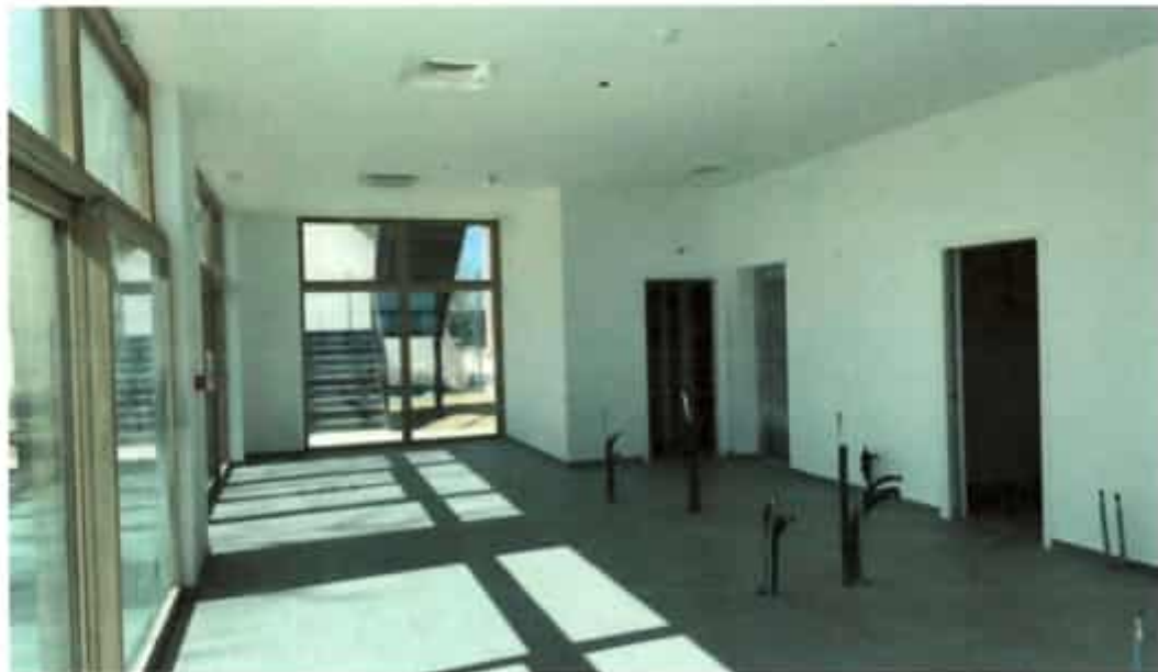
Foto n.4 – fasi di realizzazione delle predisposizioni impiantistiche a pavimento al piano terra
