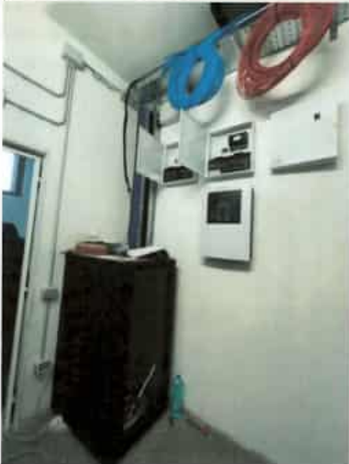
Foto n.3, 4, 5 e 6 – fasi di installazione serbatoio e fancoil per impianti meccanici, quadro elettrico e relative canaline portacavi, armadio rack dati, centralina sistema antintrusione e attrezzatura antincendio
