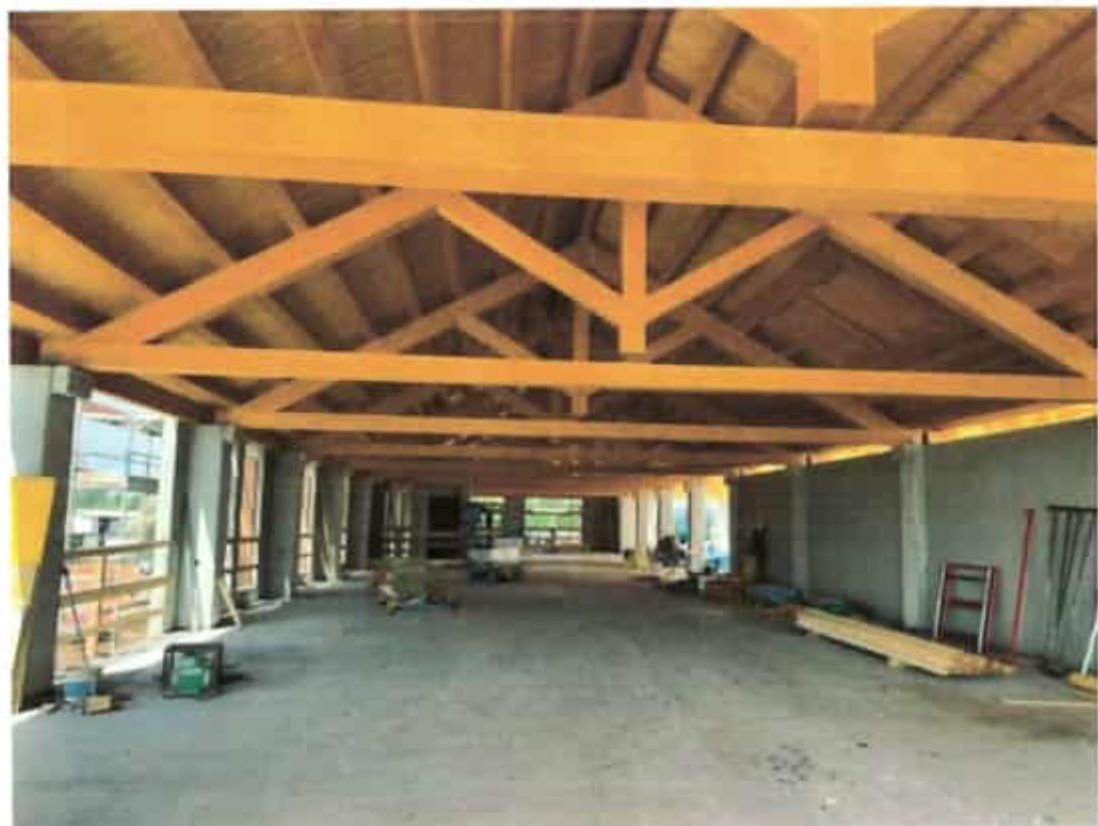
Foto n.1 e 2- fasi di realizzazione della struttura in capriate lignee di copertura del nuovo fabbricato
