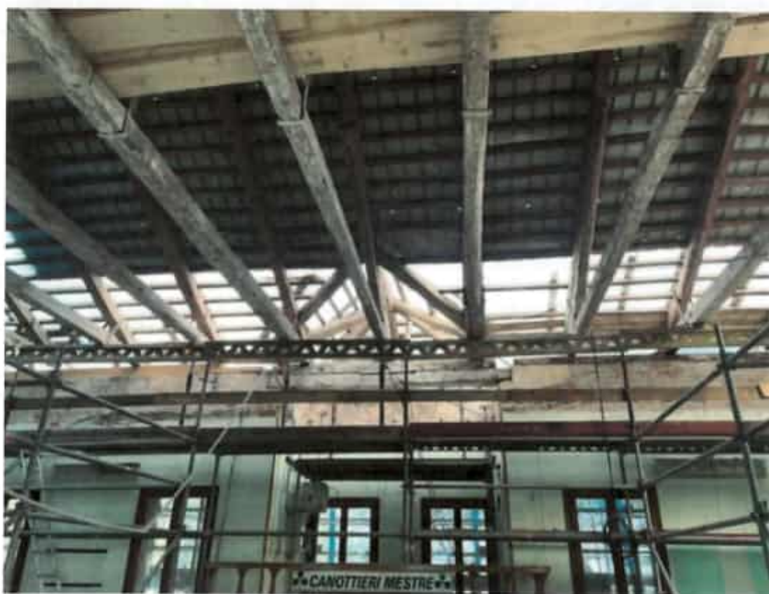
Foto n.3 e 4 – fasi di lavorazione sulle coperture e sulle capriate lignee
