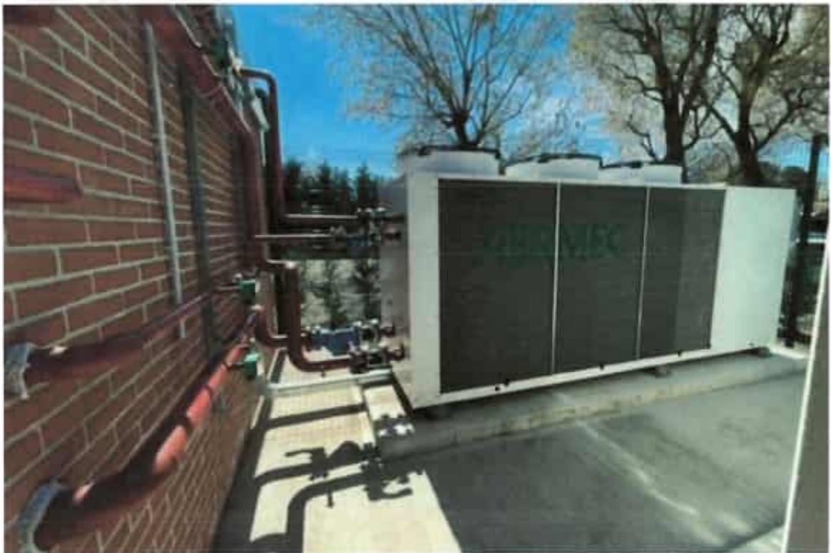
Foto n.6,7,8 e 9 – fasi di installazione e montaggio degli impianti meccanici e relativa attrezzatura e tubazioni, del quadro elettrico e del gruppo frigorifero esterno
