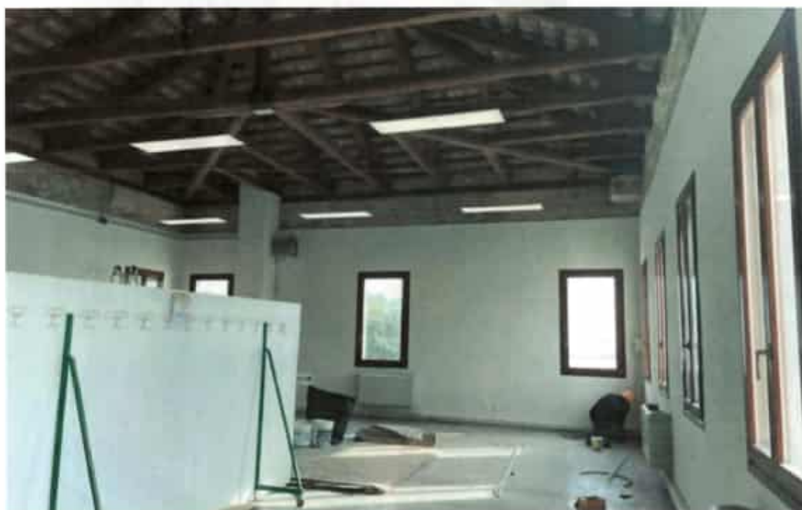
Foto n.6 e 7 – fasi di realizzazione degli intonaci nel fabbricato esistente e montaggio fancoili impianto climatizzazione
