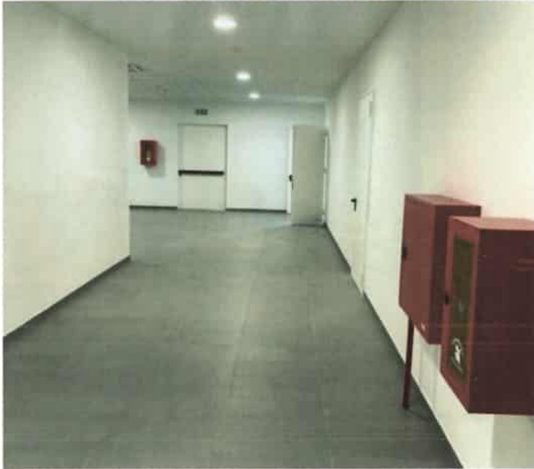
Foto n. 3 – fasi di completamento fornitura dotazioni antincendio del nuovo fabbricato
