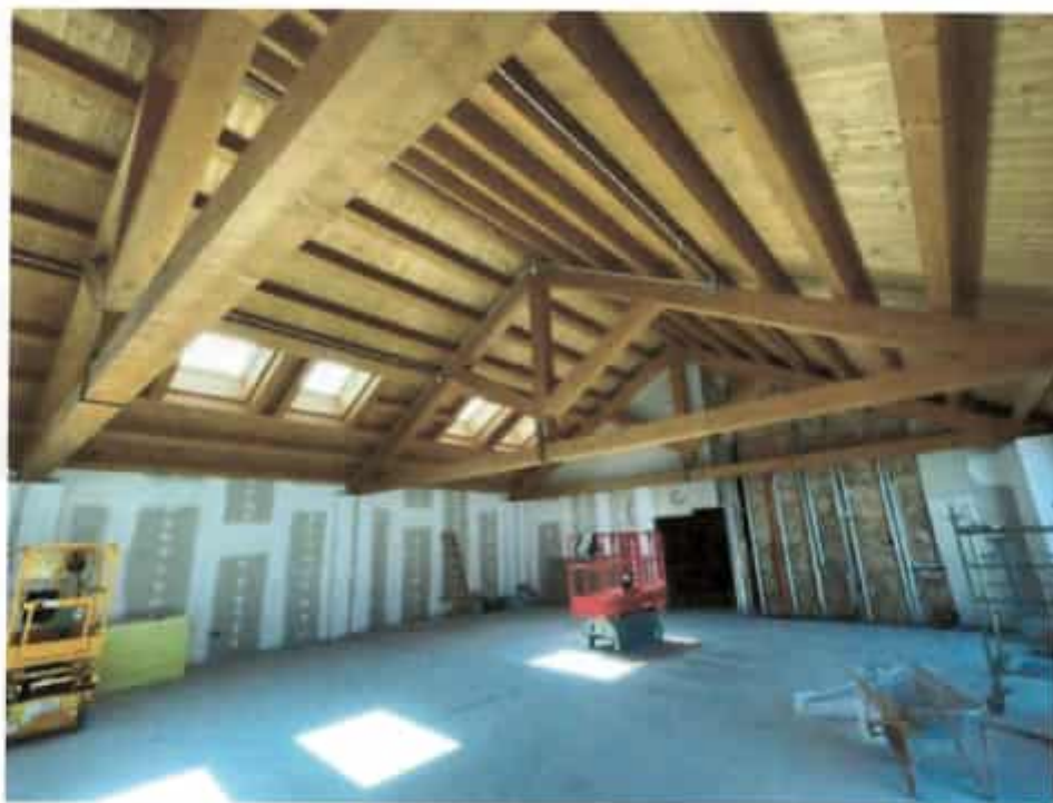
Foto n.1, 2 e 3 – fasi di realizzazione dell'intonacatura dei setti laterali e della struttura di copertura lignea ultimata anche con il montaggio dei serramenti
