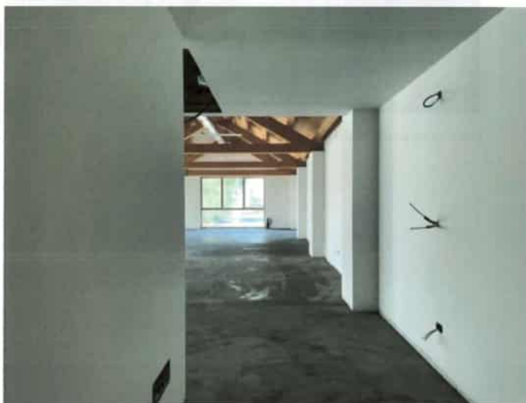
Foto n.1 e 2 – fasi di realizzazione delle tramezze prefabbricate e degli impianti elettrici del nuovo fabbricato
