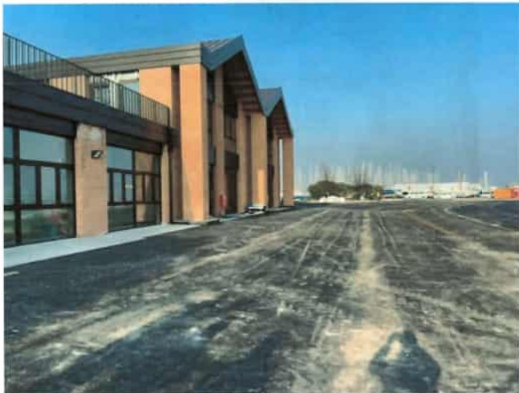
Foto n.7 e 8 – fasi di realizzazione del manufatto esterno sulla terrazza e della pavimentazione in asfalto aree esterne
