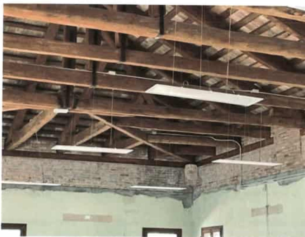
Foto n.4 – Dettaglio dei corpi illuminanti messi in opera congiuntamente ai corrugati e cassette portafrutto sulle travi
