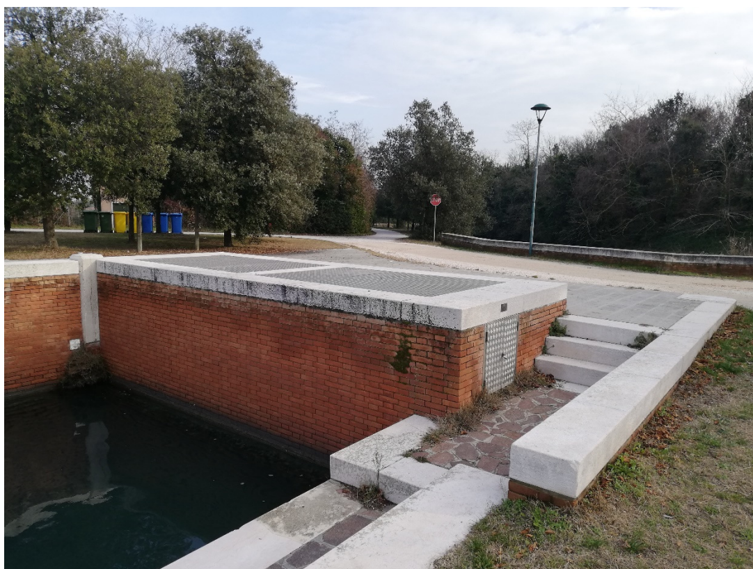
Vista della chiavica N. 34 dalla darsena della Torre Massimiliana
