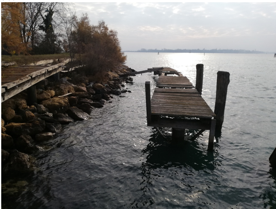
Vista del pontile e della passerella in direzione bocca di porto San Nicolò
