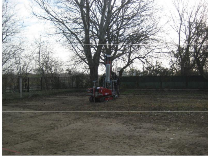
Foto 1: Esecuzione della prova CPTU1
