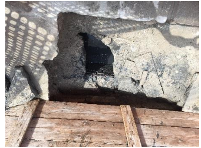
Foto 3 Realizzazione pozzetto d'ispezione
