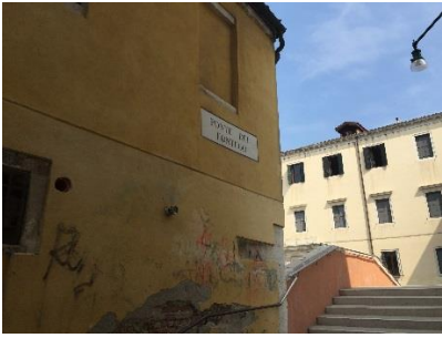
Foto 1 – identificazione del sito
