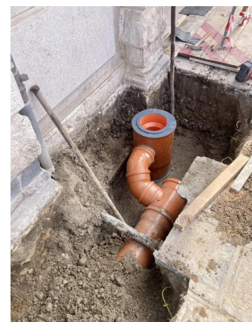
Pozzetto posato provvisoriamente
