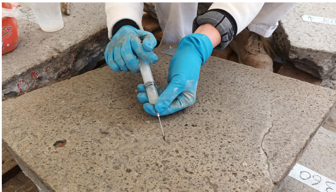
Figura 4–3 Iniezioni di consolidamento.
