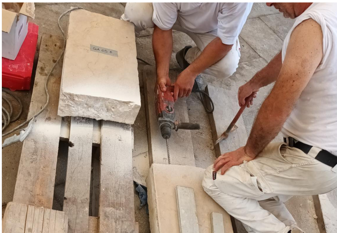
Figura 4-2 Realizzazione dei fori per l'inserimento dei perni in CFRP di ricucitura della lista di pietra d'Istria.
