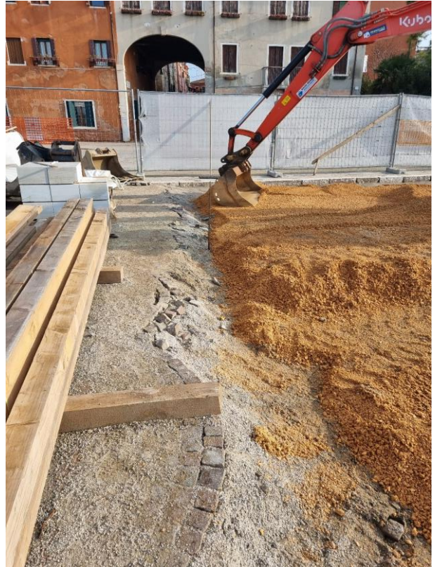
La stesura del misto stabilizzato
