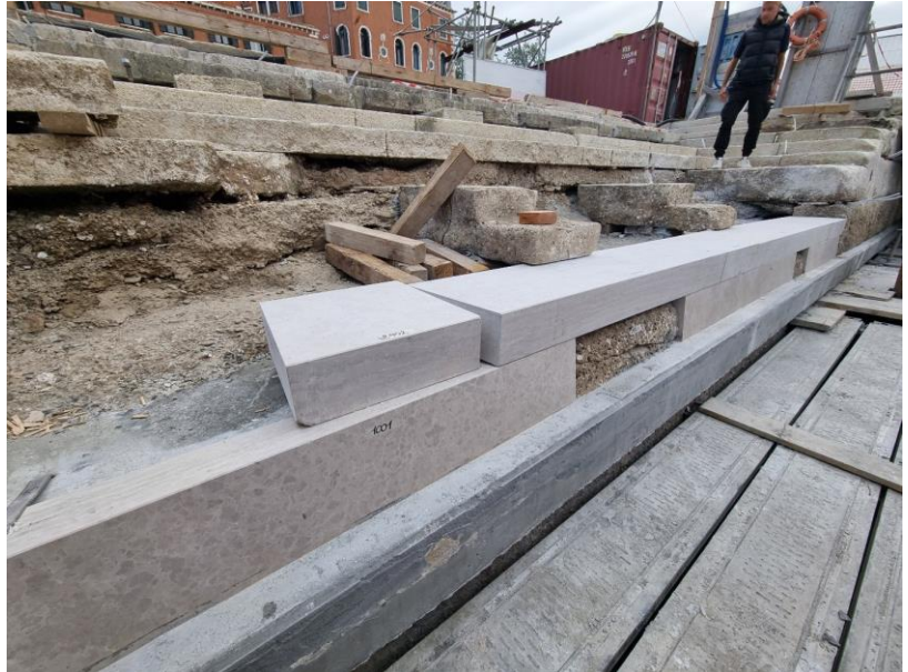
Riva d'acqua ovest durante i lavori: il cordolo di protezione e i nuovi blocchi lapidei
