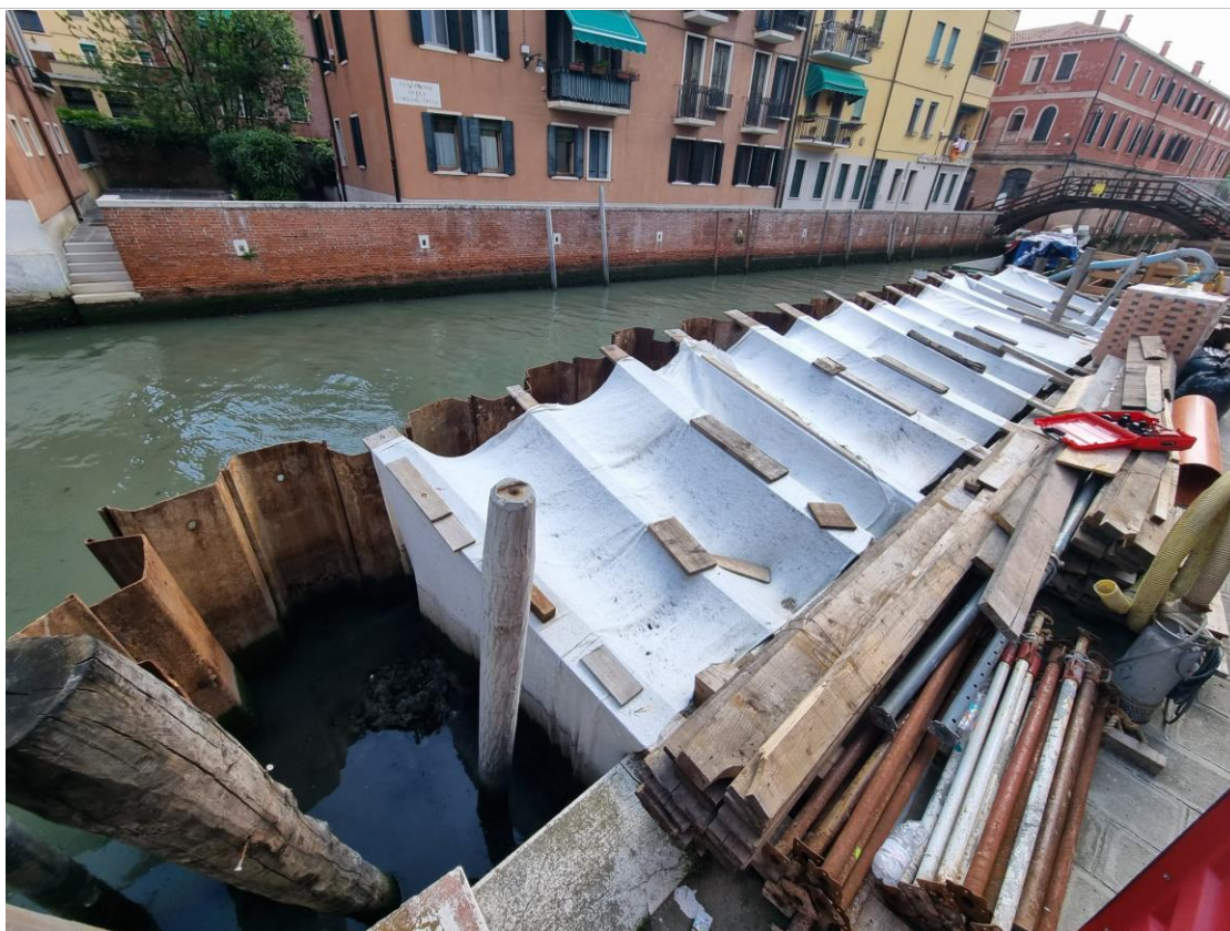
Prolungamento del cassero per consentire lo stoccaggio provvisorio dei fanghi escavati
