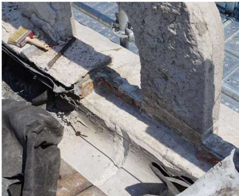
Fronte A – cornice sommitale interna sondaggio effettuato al piede del merlo 005 che ha confermato che il concio in pietra è unico per una profondità complessiva pari a circa 80cm
