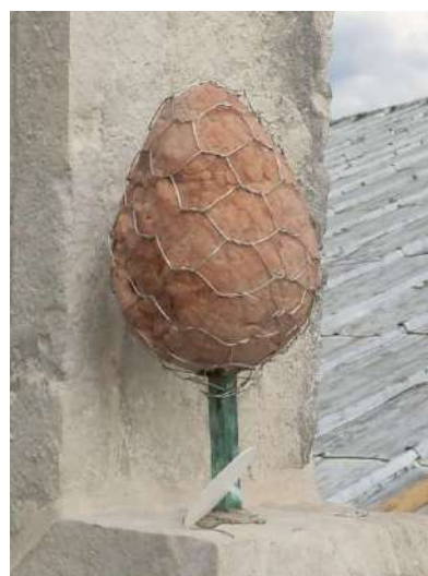
Messa in sicurezza pigna – foto campione
