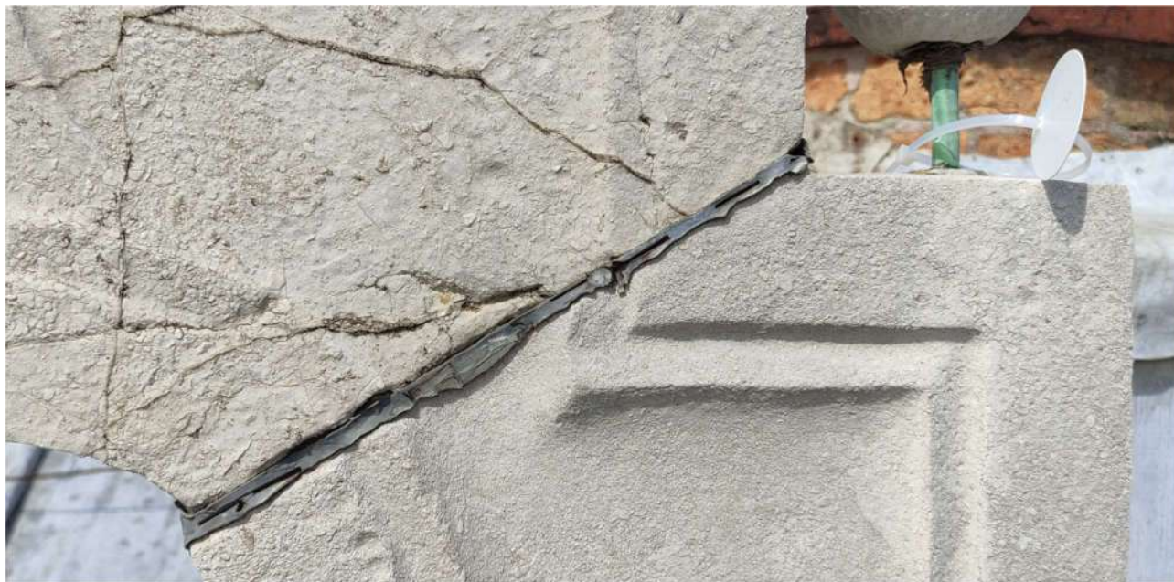
Merlo M-01, Fronte A – giunto lineare in piombo sconnesso e ammalorato
