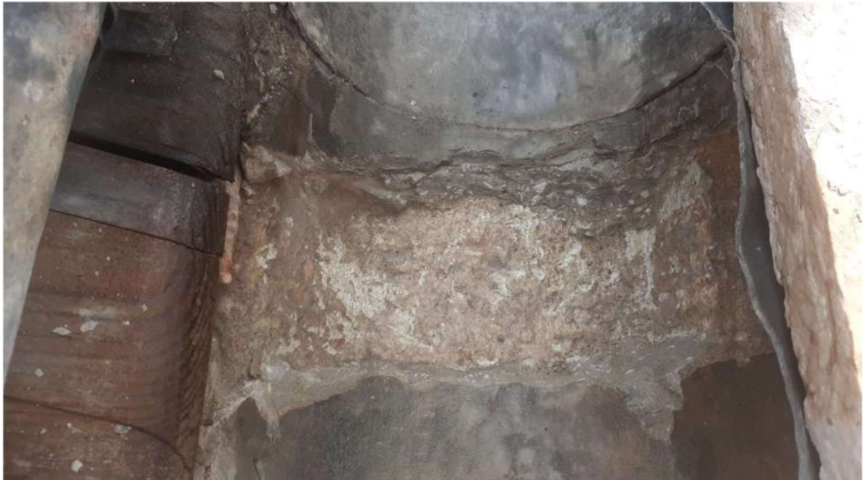
Fronte B – cornice sommitale interna, sondaggio effettuato al piede del merlo 023 che ha confermato che il concio in pietra è unico per una profondità complessiva pari a circa 80cm
