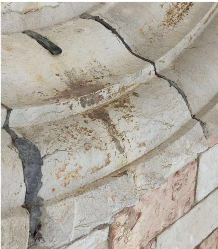
Merlo M-05, Fronte A – giunto lineare in piombo sconnesso e ammalorato e giunto puntuale sconnesso
