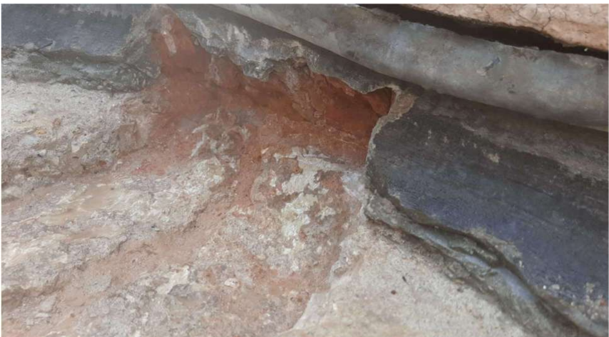
Fronte B – cornice sommitale interna, sondaggio effettuato al piede del merlo 012 che ha confermato che il concio in pietra è unico per una profondità complessiva pari a circa 80 cm
