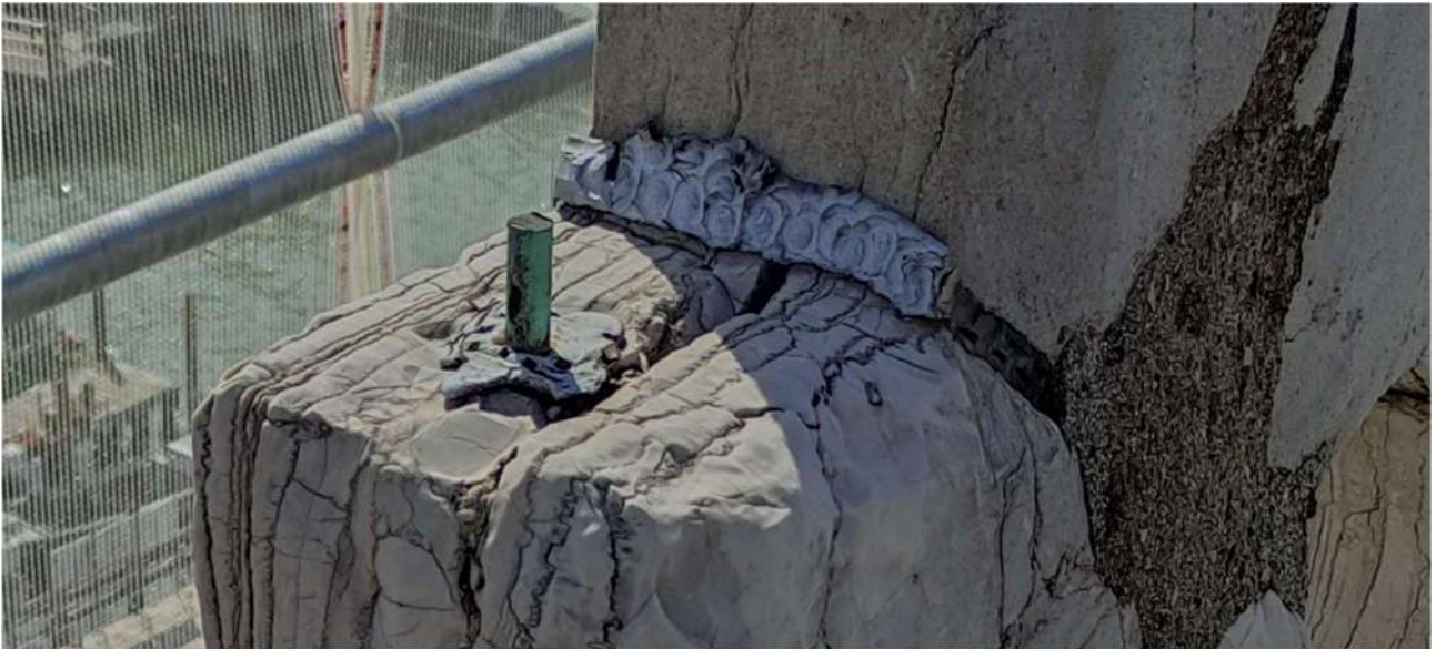
Merlo M-05, Fronte A – giunto lineare in piombo sconnesso e ammalorato e giunto puntuale sconnesso
