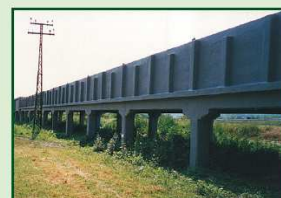
CANALE IDROELETTRICO Piemonte - ITALIA
