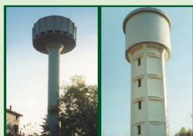
TORRI PIEZOMETRICHE Bologna - ITALIA
