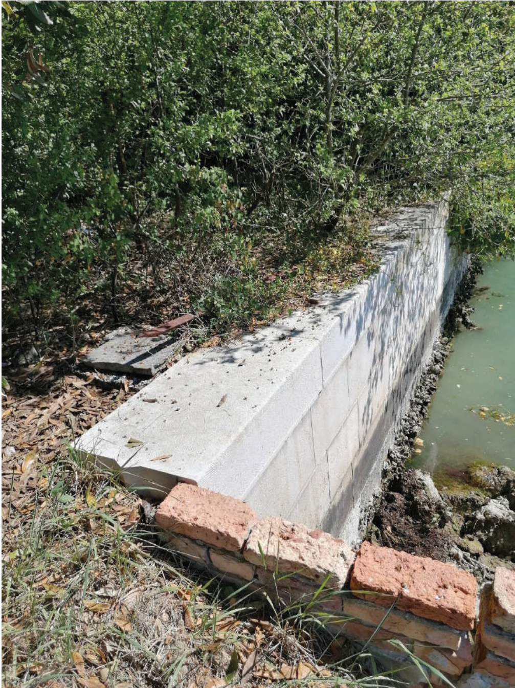
Figura 8 – Attracco muro dissestato e marginamento
