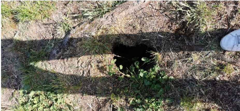
Figura 9.3: Delimitazione della zona interessata dall'apertura di piccole voragini determinate dallo svuotamento del terreno sottostante
