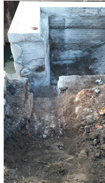
Figura 2.3: Scavo per la realizzazione del collegamento tra le rive, con messa in luce della struttura in c.a. del muro di sponda
