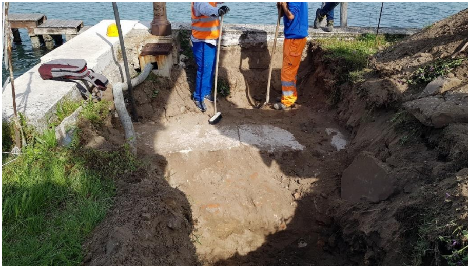
Figura 2.1: Sondaggio eseguito con scavo e ritrovamento dell'originale marginamento allineato con quello ancora in uso
