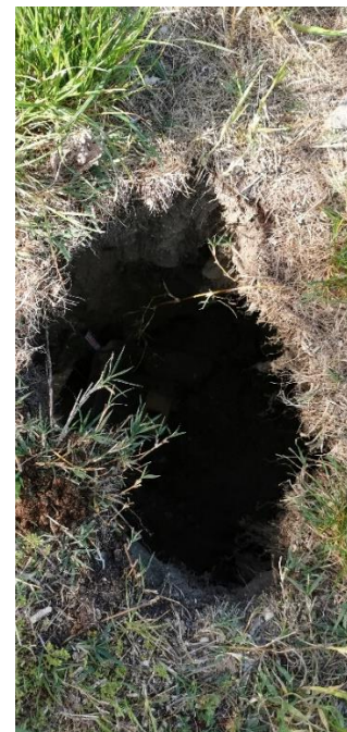
Figura 1.5: Cedimenti con svuotamento del terreno in corrispondenza alla riva più alta in calcestruzzo
