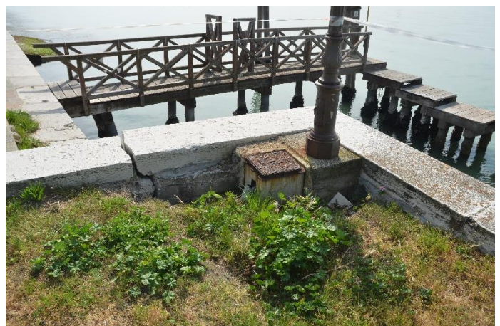
Figura 1.3: Svuotamento del terreno alle spalle del marginamento
