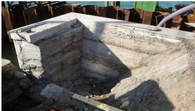
Figura 2.3: Scavo per la realizzazione del collegamento tra le rive, con messa in luce della struttura in c.a. del muro di sponda
