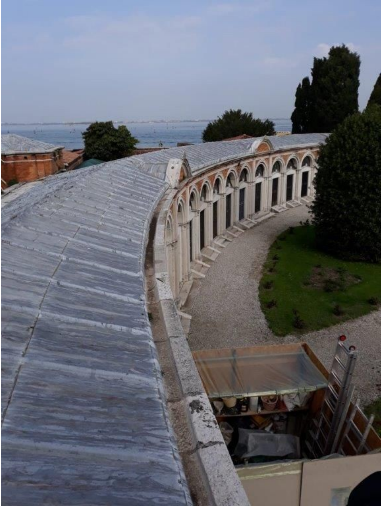
Vista del tetto plumbeo e del canale di gronda in pietra dell'emiciclo
