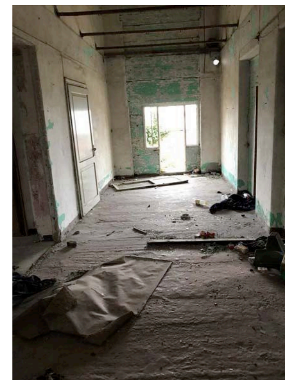
CORRIDOIO PIANO PRIMO
