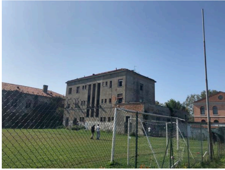
FOTO PROSPETTO NORD-EST
