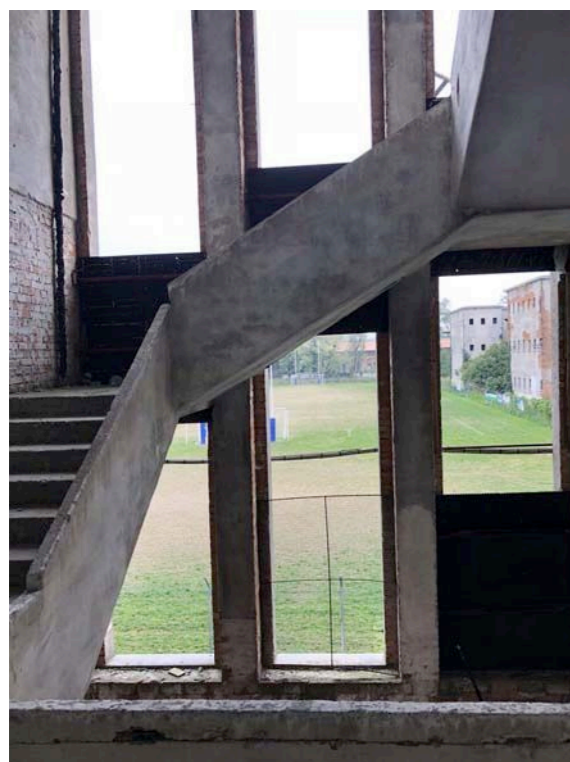
INTERNO VANO SCALE
