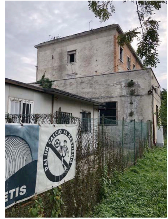
FOTO PROSPETTO NORD-OVEST
