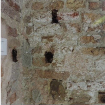
Fig.3 Trattamento di desalinizzazione per la muratura a faccia vista
