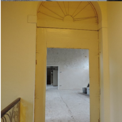
Fig.5 Restauro di alcune porte storiche
