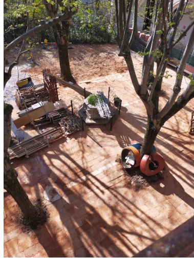
Fig.7 Recupero ed integrazione pavimentazione del chiostro
