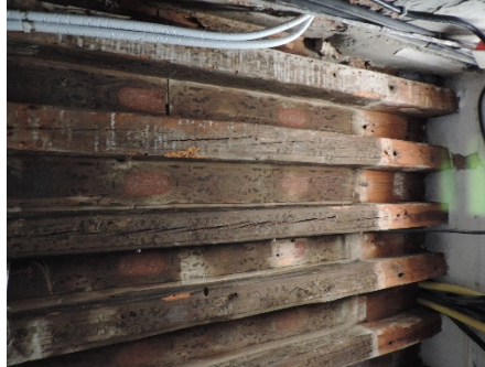
Fig.4 Pulizia e restauro delle strutture lignee a vista
