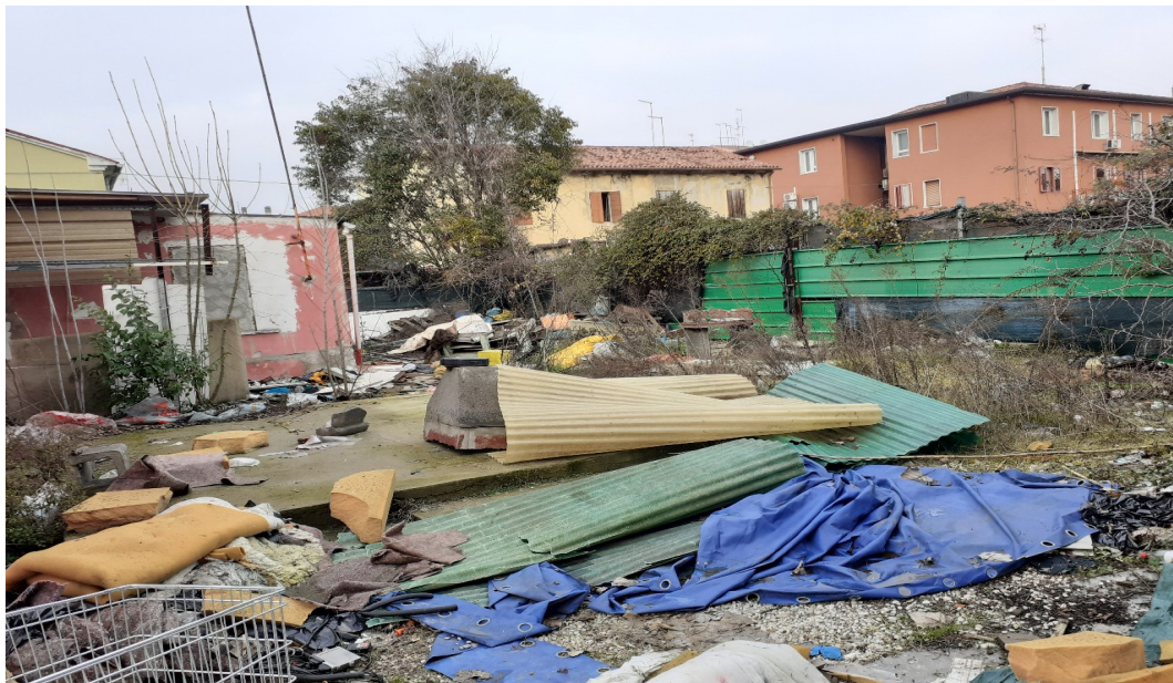
Stato dei luoghi prima dell'inizio lavori dello stralcio I
