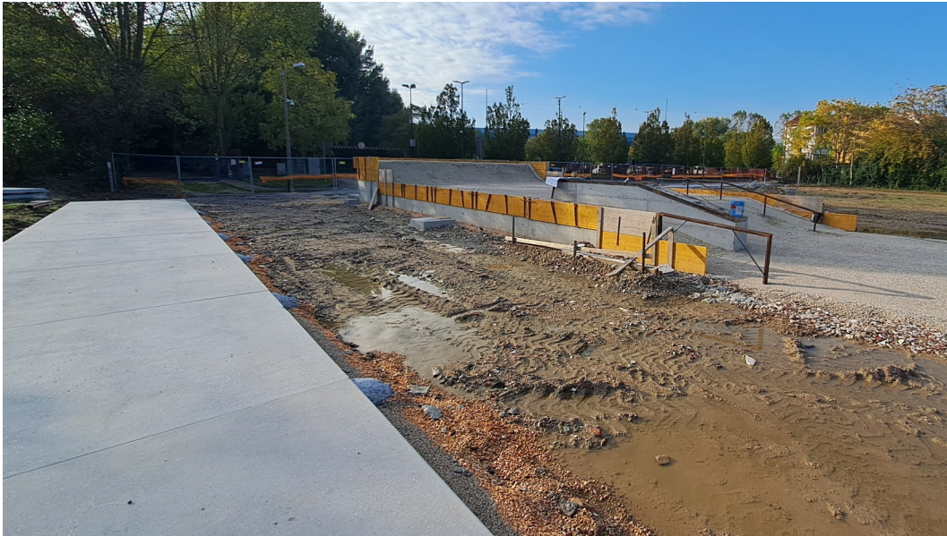
Esecuzione dei lavori - stralcio I
