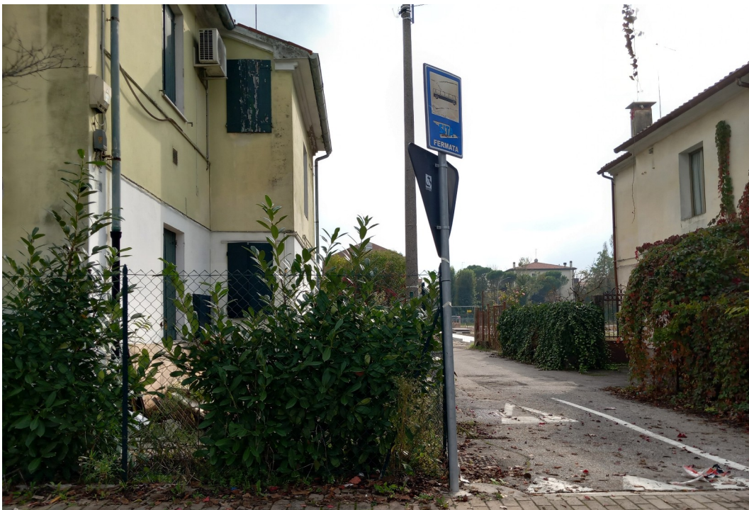
Edifici lungo via Trieste da demolire
