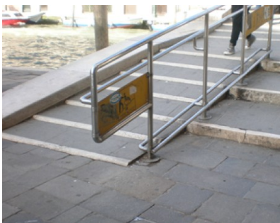
Figura 8: ponte de le Guglie, rampa fissa esistente a gradino agevolato, lato rio terrà S. Leonardo.
