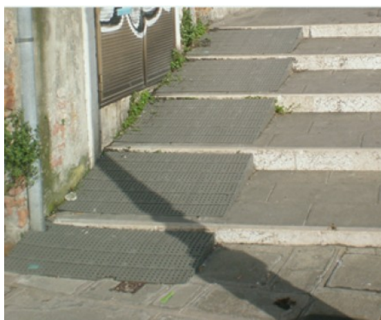
Figura 7: ponte de le Guglie, la rampa amovibile che è stata rimossa, lato fondamenta de Ca' Labia.
