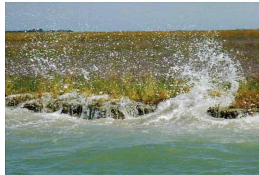
*In basso, strutture filtranti poste a protezione di bassifondi contro l'azione erosiva del moto ondoso (velme in area di Burano) analoga struttura formata con fascinate a media resistenza dopo 12 mesi dalla costruzione.*
