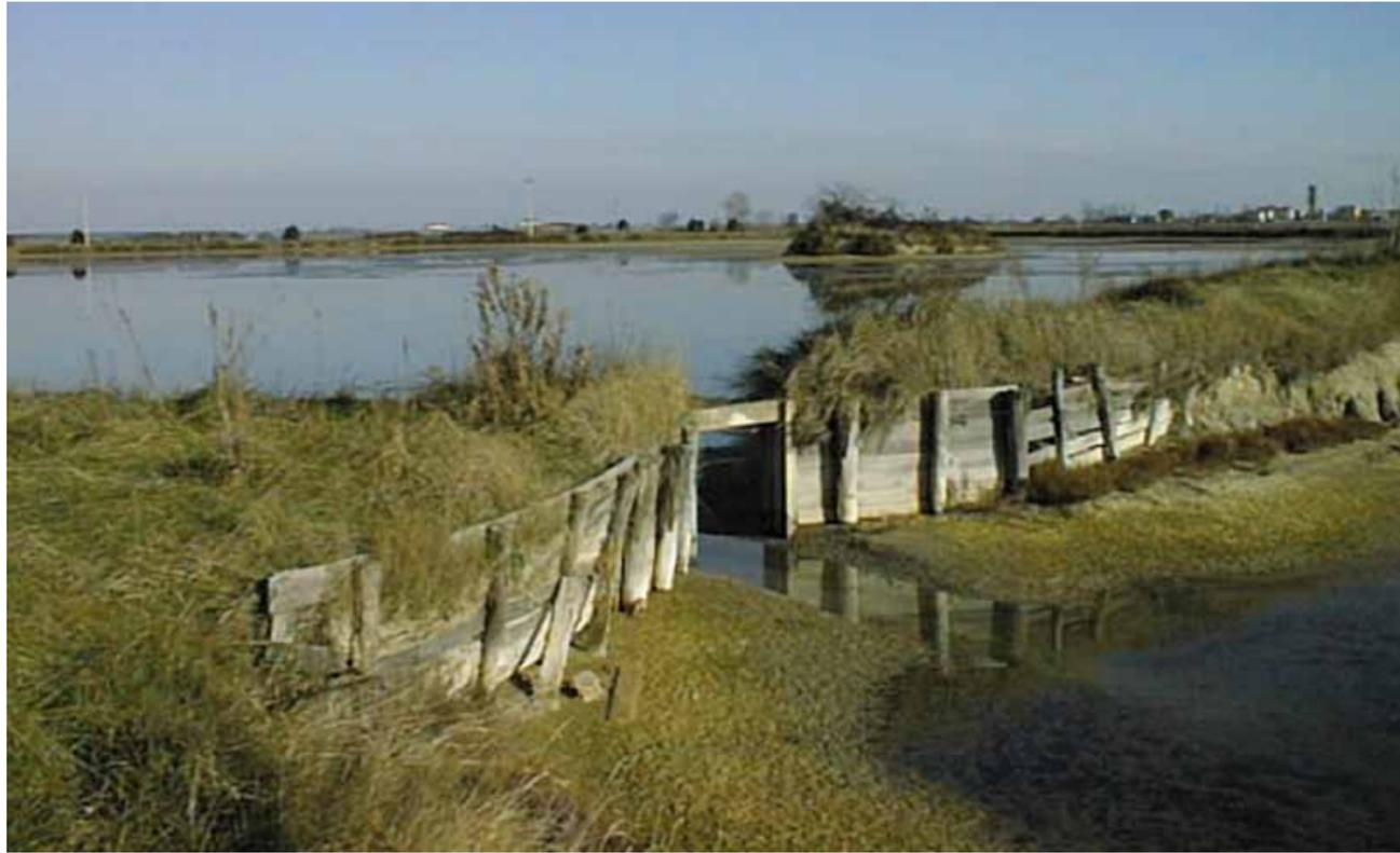
*Sopra e a fianco, strutture per la regolazione dei livelli all'interno di una valle della laguna superiore. I materiali utilizzati e la tecnica costruttiva fanno cogliere in pieno la precarietà della separazione tra zona e zona all'interno di una stessa valle da pesca, dove la configurazione di alcune parti è soggetta a frequenti modifiche in funzione delle diverse esigenze di gestione.*
