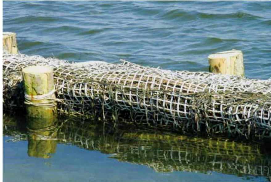
Struttura di perimetrazione per la protezione e l'ampliamento di una barena con la posa in opera di burghie ad alta e media resistenza.
