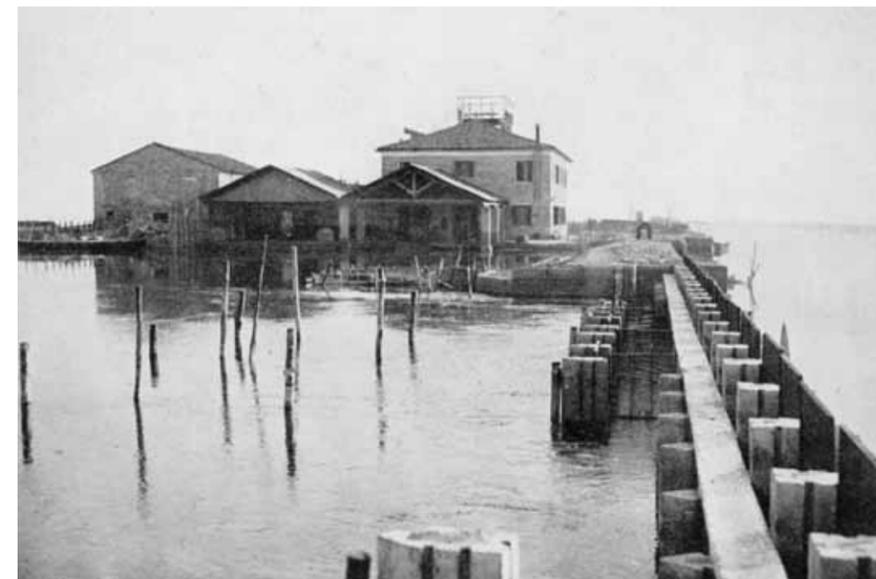
A fianco, immagini fotografiche di Valle Dogà e delle sue strutture per controllo degli scambi d'acqua valle-laguna. Si tratta di strutture formate con una serie di luci ricavate tra pilastrini in calcestruzzo, ancorati a una soglia di fondo a sua volta in calcestruzzo, poste in sostituzione degli antichi parè di grisiolo.
