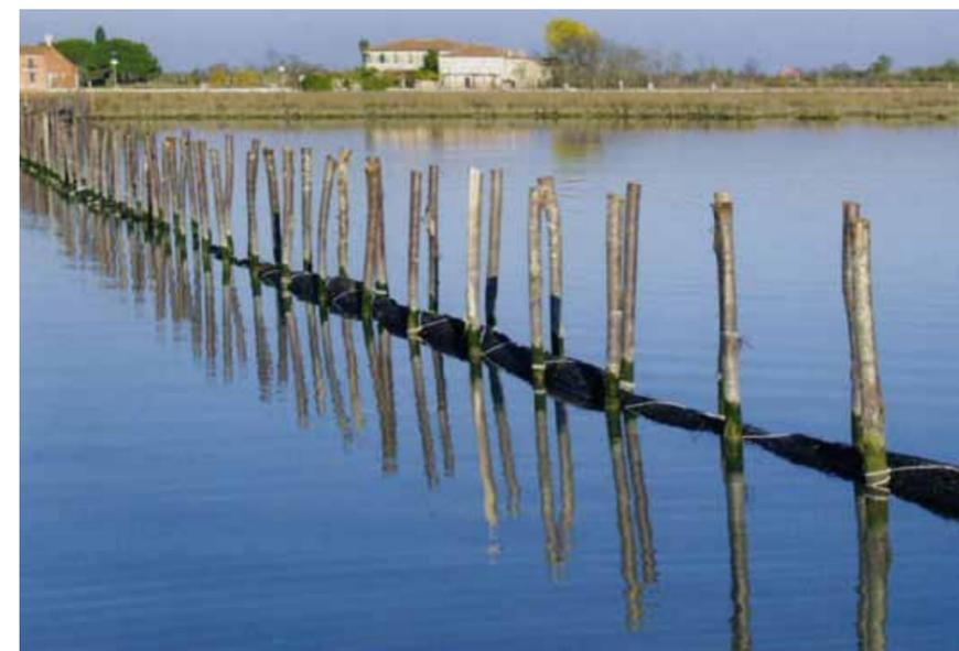
Strutture filtranti poste a protezione di bassifondi contro l'azione erosiva del moto ondoso (barena di Punta Vecia) l'opera è formata con una struttura di pali infissi e l'inserimento di fascinate avvolte da geogriglia.
