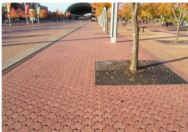
**Figura 15. Pavimentazione permeabile**
