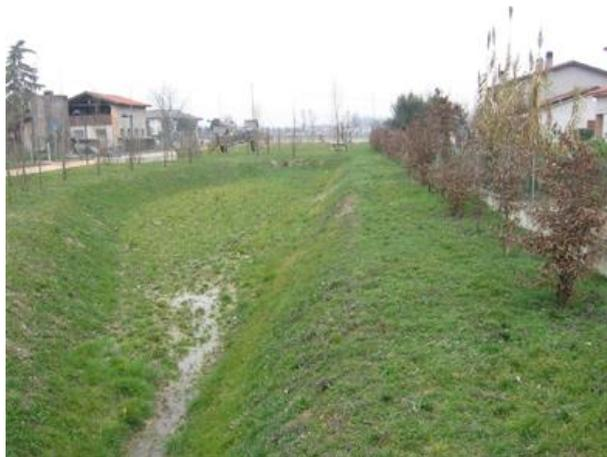
**Figura 13. Bacini infiltrazione**
