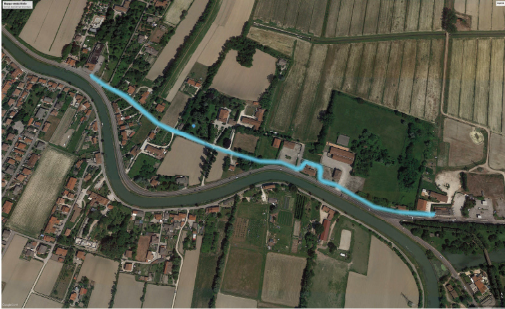
Vista aerea della zona di intervento, in località Ca' Sabbioni
