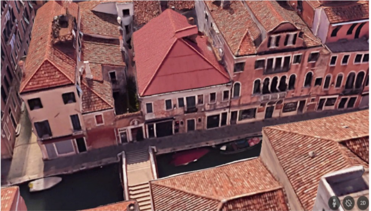
Ripresa dall'alto (Google Earth): portale d'accesso ai piedi del ponte e vista della calle privata
