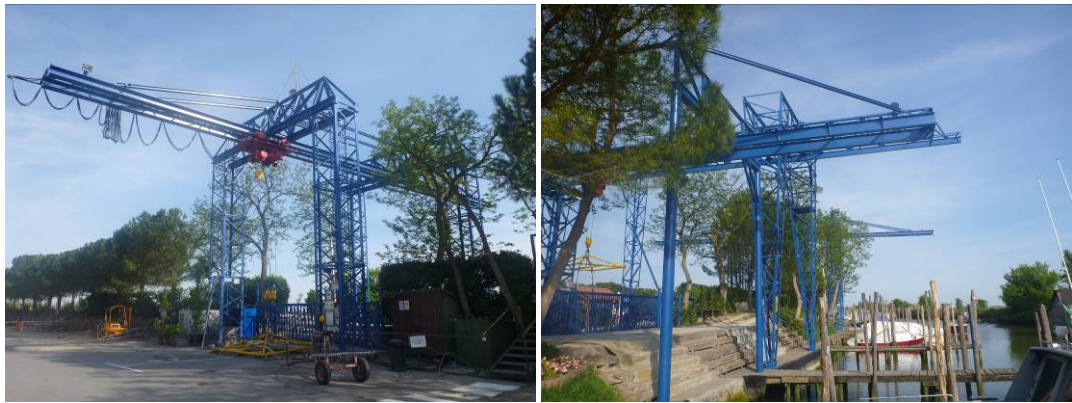
Figura 10 carriponte, vista da terraferma e lato canale
