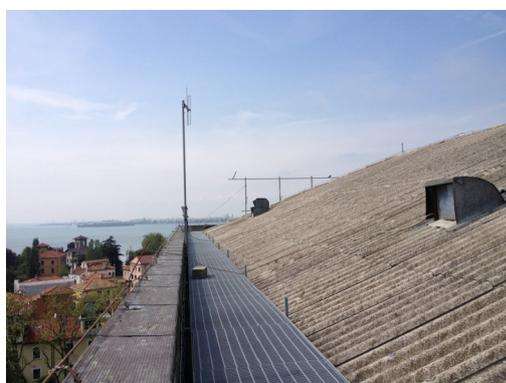
*Foto 5 - Passerella parallela alla cornice del tetto*
