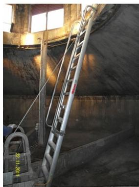
Foto 10 – Scala fissa in alluminio del tipo a pioli
