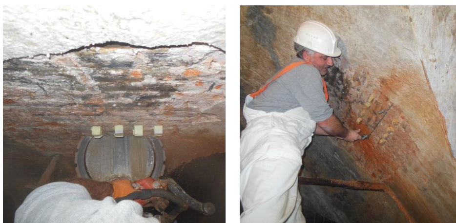
Figura 3-11: esecuzione del taglio nella muratura e inserimento del martinetto all'interno del taglio
