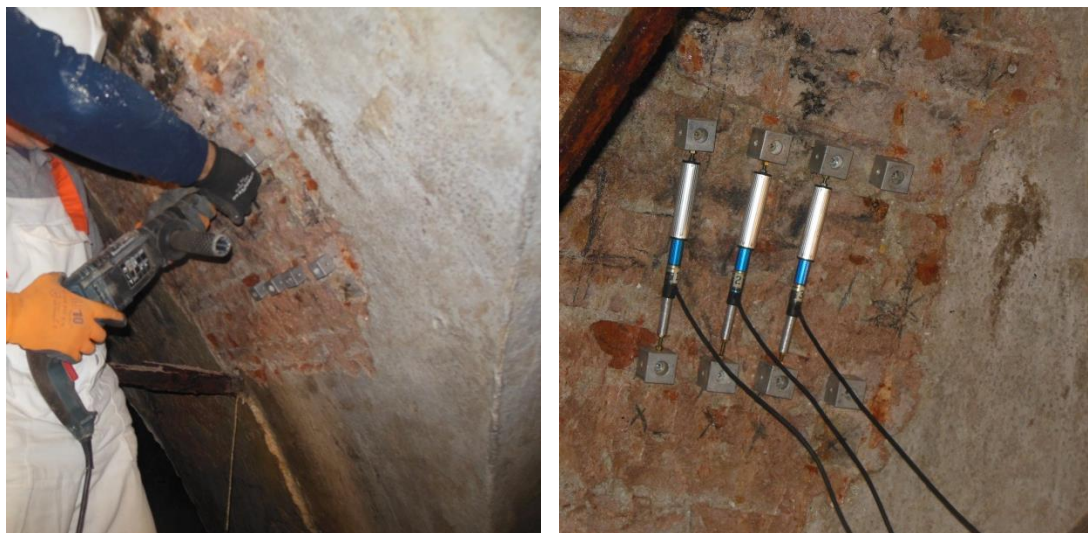
Figura 3-10: fissaggio delle basi di misura, test di martinetto piatto singolo
