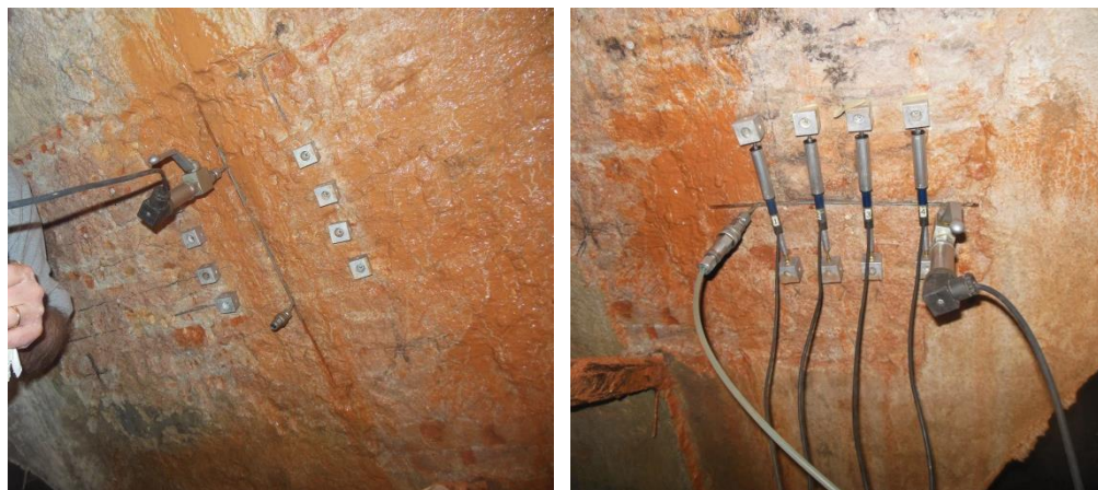
Figura 3-12: martinetto inserito all'interno del taglio: da sinistra il tubo di ingresso dell'olio all'interno del martinetto, i sensori di spostamento ricollocati nelle precedenti posizioni, il trasduttore di pressione
