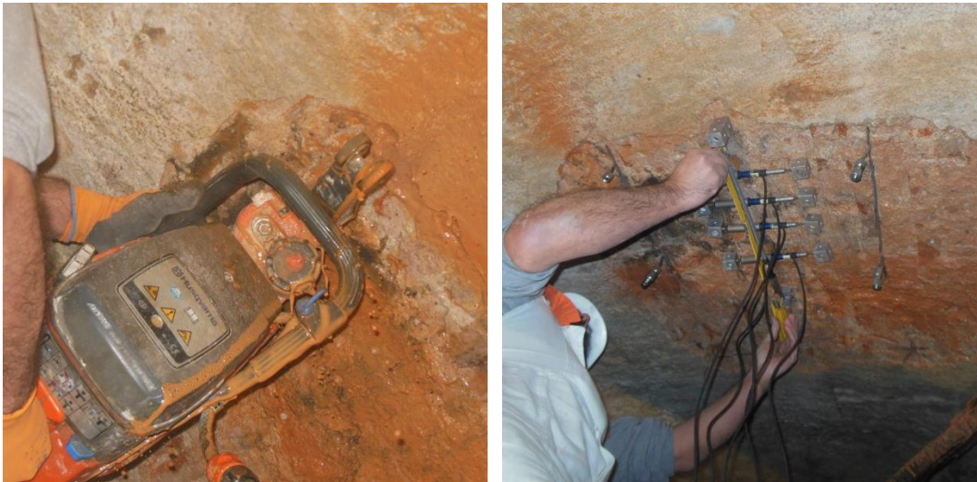
Figura 3-21: prova con martinetto piatto doppio MPD 1 – Esecuzione del secondo taglio e disposizione dei sensori
