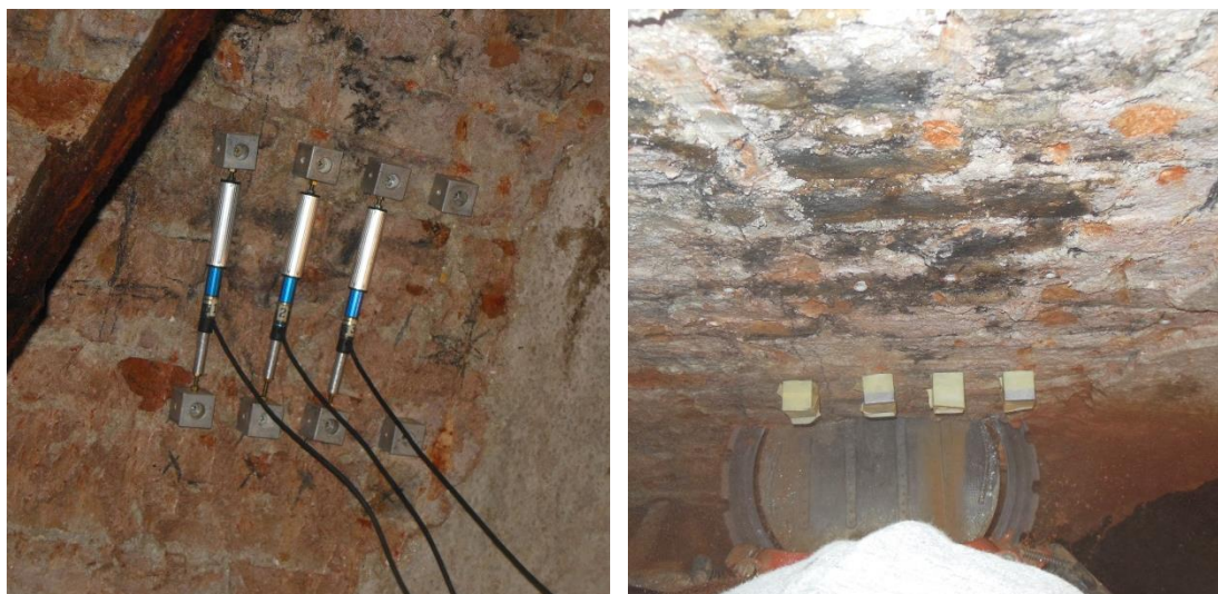
Figura 3-19: prova di martinetto piatto singolo MPS 1; individuazione prova; misura delle distanze iniziali; esecuzione del taglio
