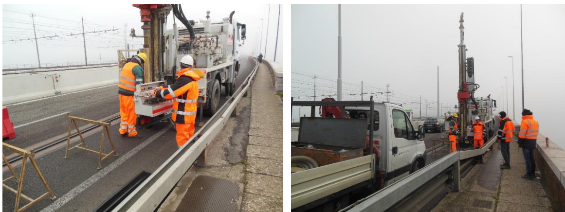
Figura 4-2: esecuzione dei carotaggi
