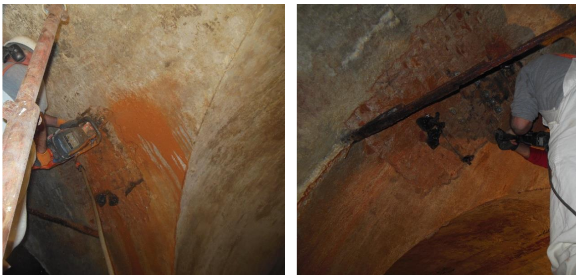
Figura 3-13: esecuzione del taglio nella muratura e fissaggio delle basi di misura
