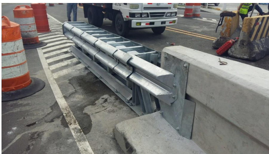
Figura 11: Esempio di collegamento tra SMA A/T 80/1 e barriera in calcestruzzo.
