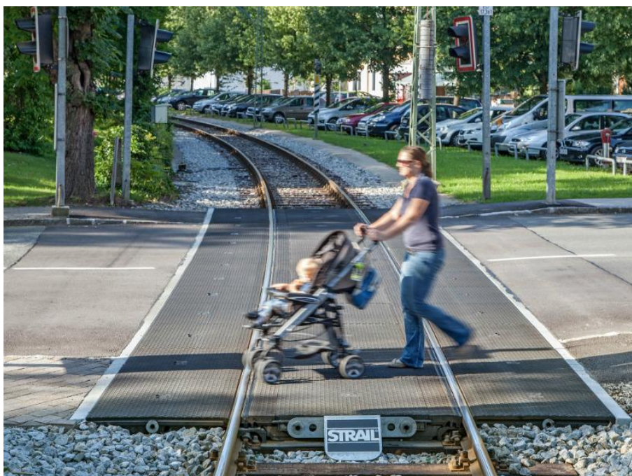
Figura 11: Attraversamento ferroviario con sistema STRAIL
