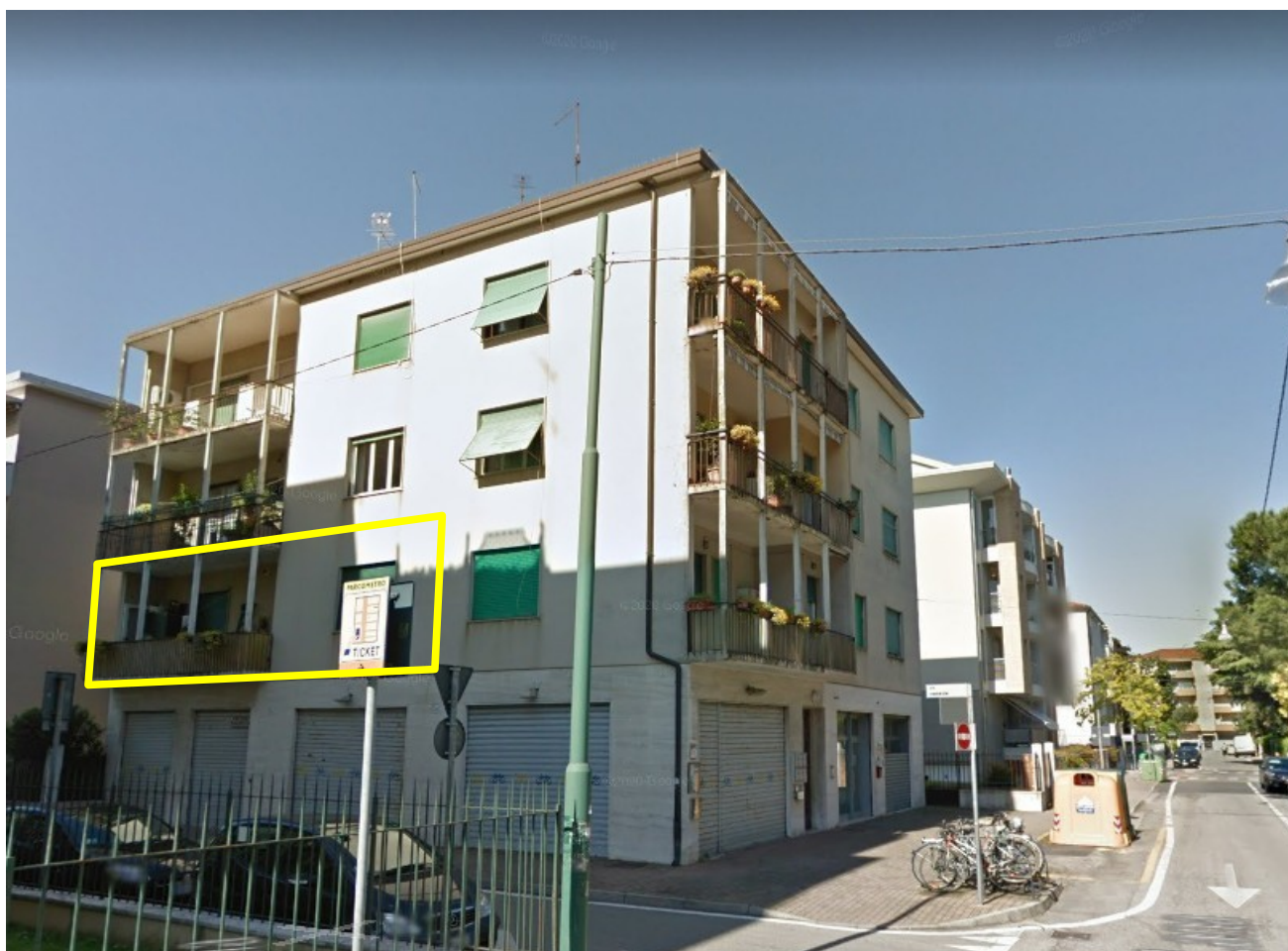
Foto 1 – Vista generale del complesso immobiliare con individuazione dell'appartamento interessato
