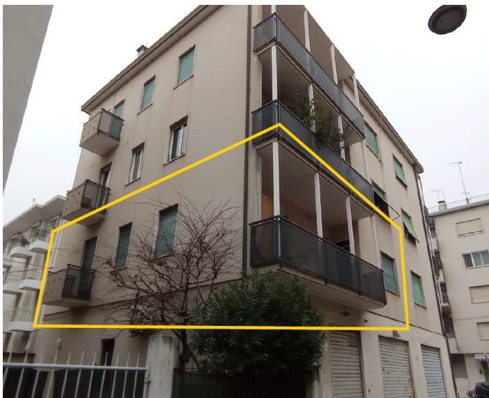
Foto n. 13 – Vista alloggio da via Venezia
