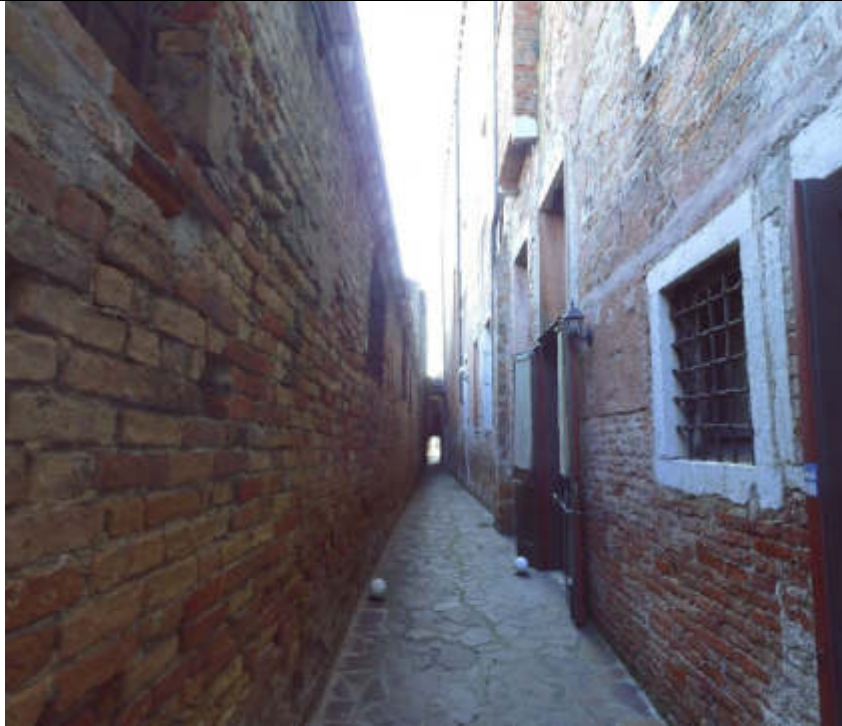
3 Prospetto Ovest, vista da calle interna
