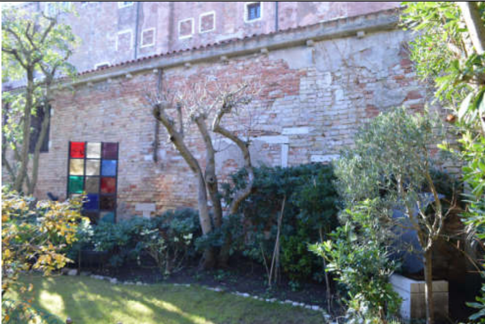
4 Prospetto Est, vista da giardino privato
