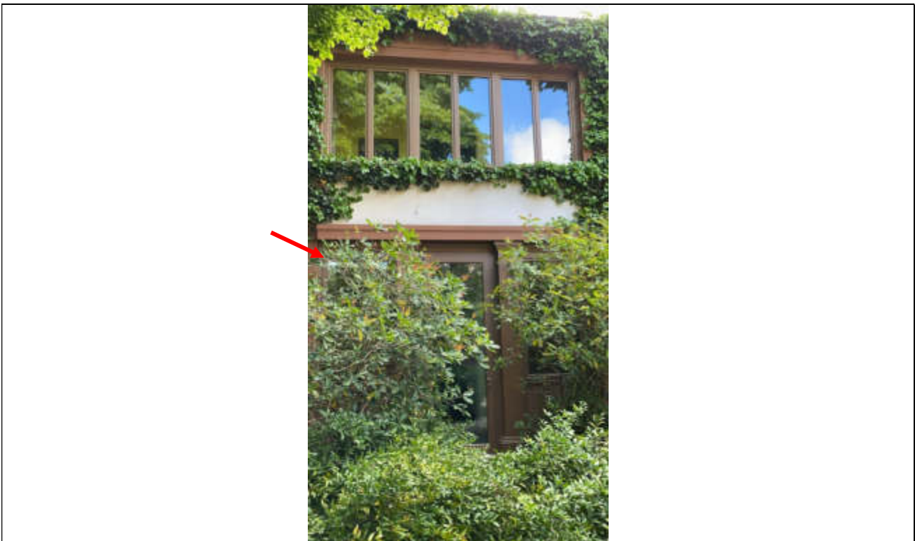
8 Prospetto Nord, ingresso principale oggetto di intervento
