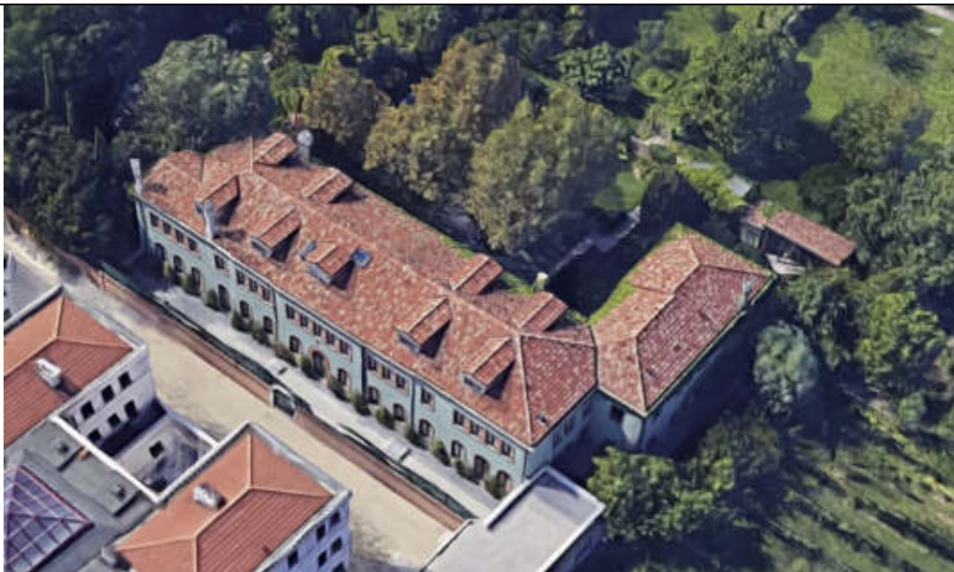
8 Vista aerea copertura, Google Maps
