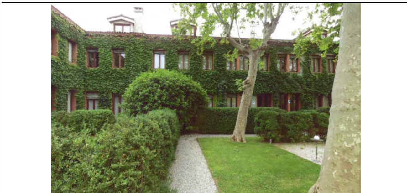
2 Prospetto Nord, corpo centrale
