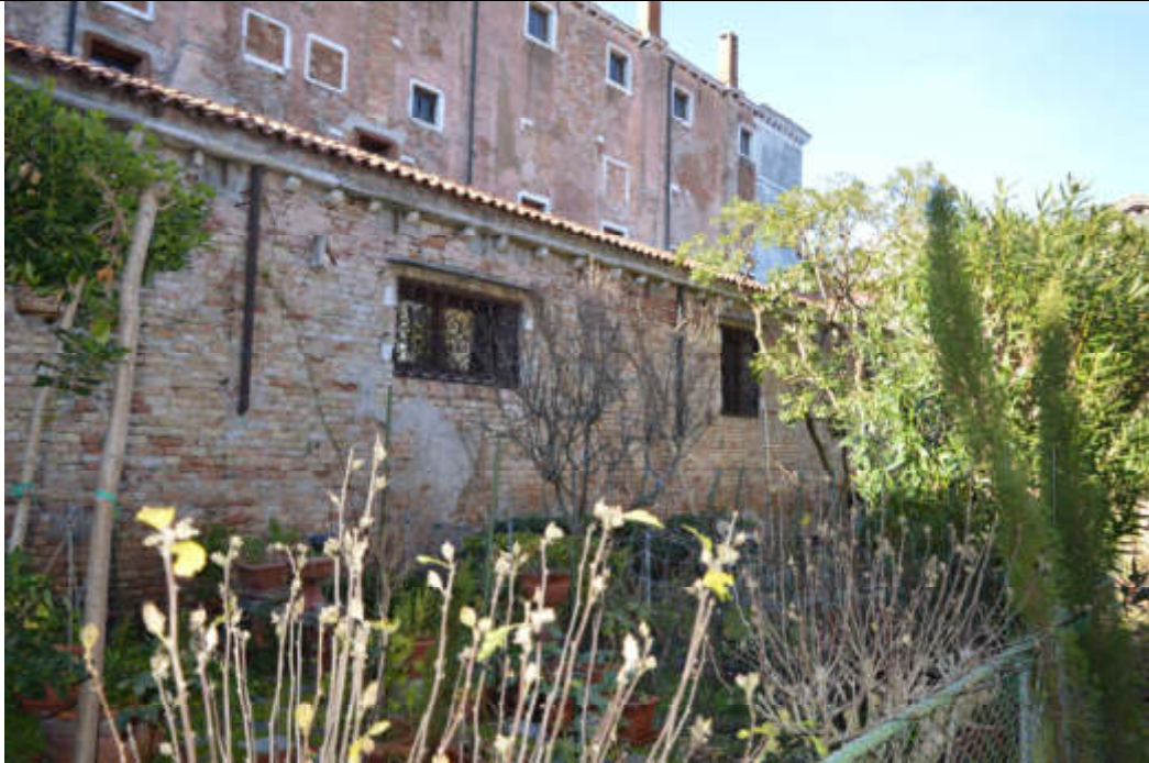
5 Prospetto Est, vista da giardino privato
