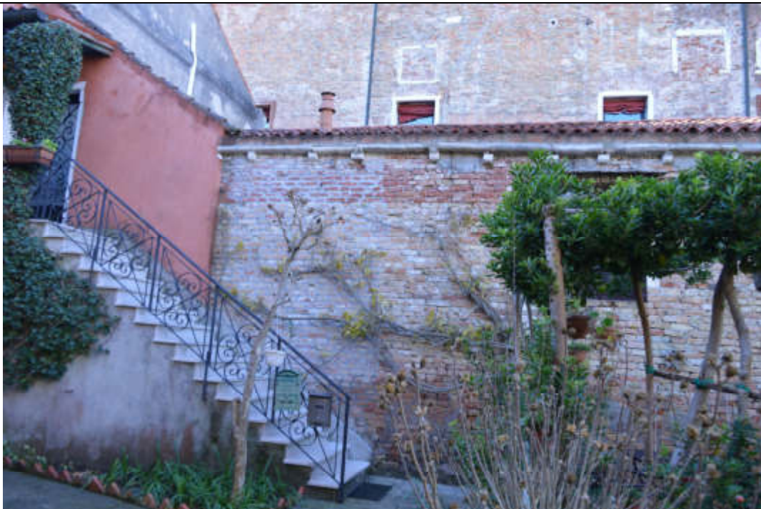
6 Prospetto Est, vista da giardino privato
