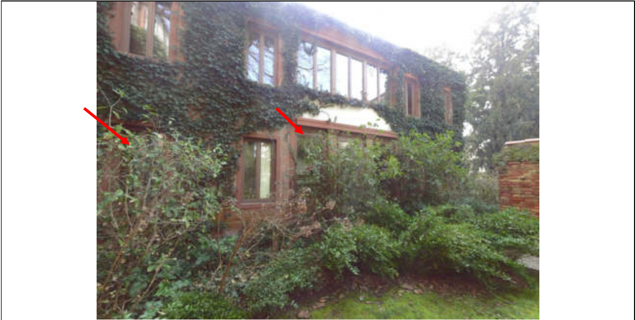
7 Prospetto Nord, finestra e ingresso principale oggetto di intervento
