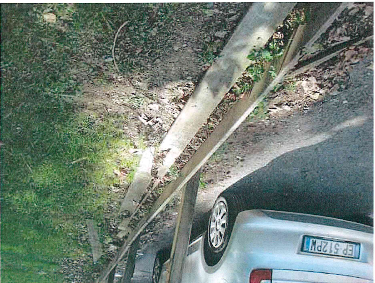
2. Area Bissagola recinzione
