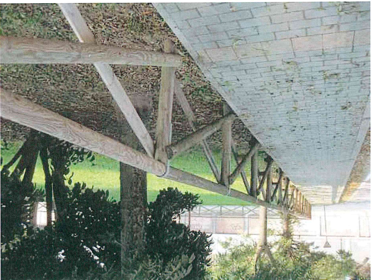
2. Area Parco Ferroviario
