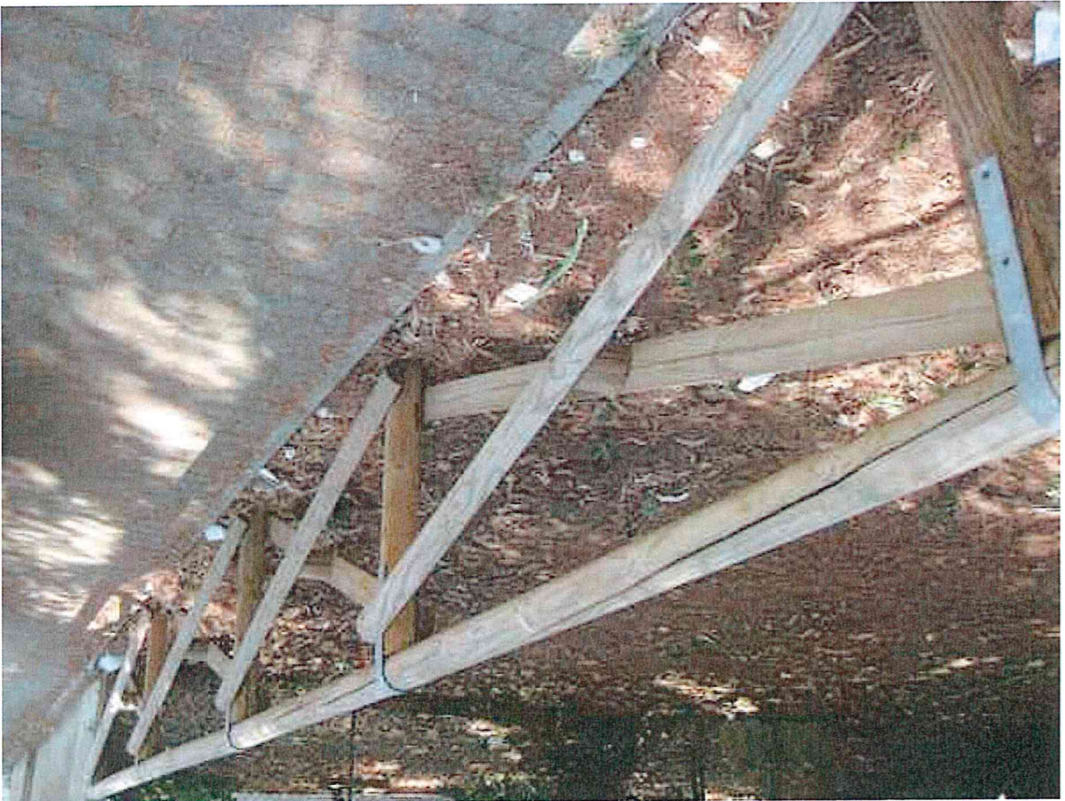
4. Area Parco Ferroviario
