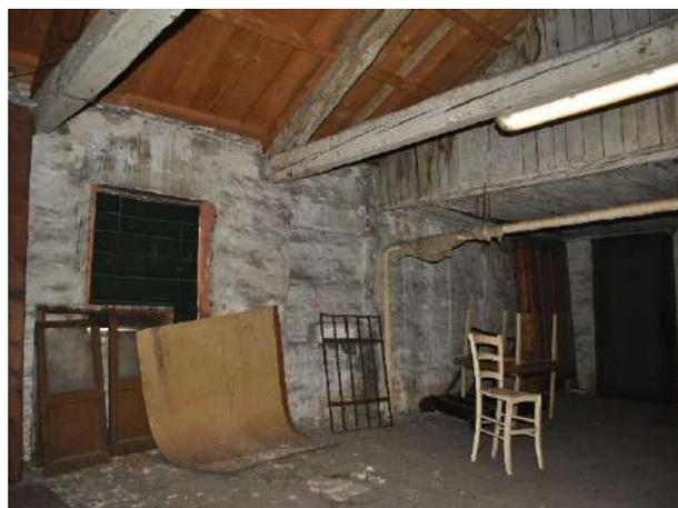
L'**edificio C**, ad un piano fuori terra, si presenta parzialmente crollato. È costituito da murature in mattoni pieni di spessore 25 cm e copertura in legno, dove presente. Si osserva che la porzione superiore della muratura perimetrale lungo il rio risulta essere costituita da mattoni forati.
