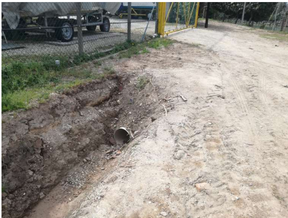
Figura 4.2 – La condotta terminale Ø300 mm esistente
