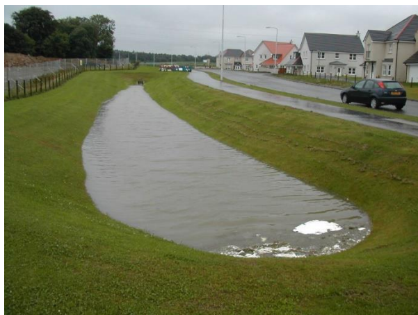
Figura 14. Bacino di detenzione
