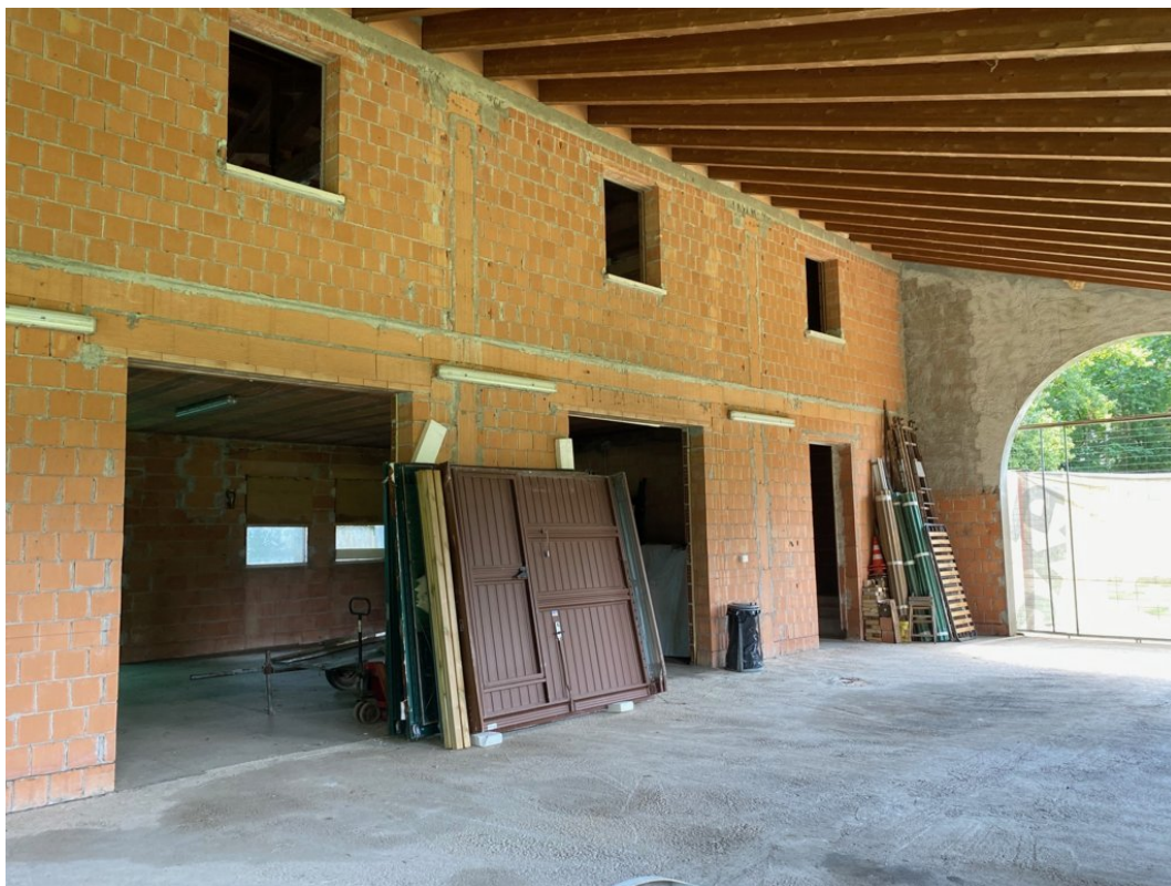
9- FOTO NUM.9, VISTA INTERNA DAL PORTICATO VERSO L'INTERNO P.T.
