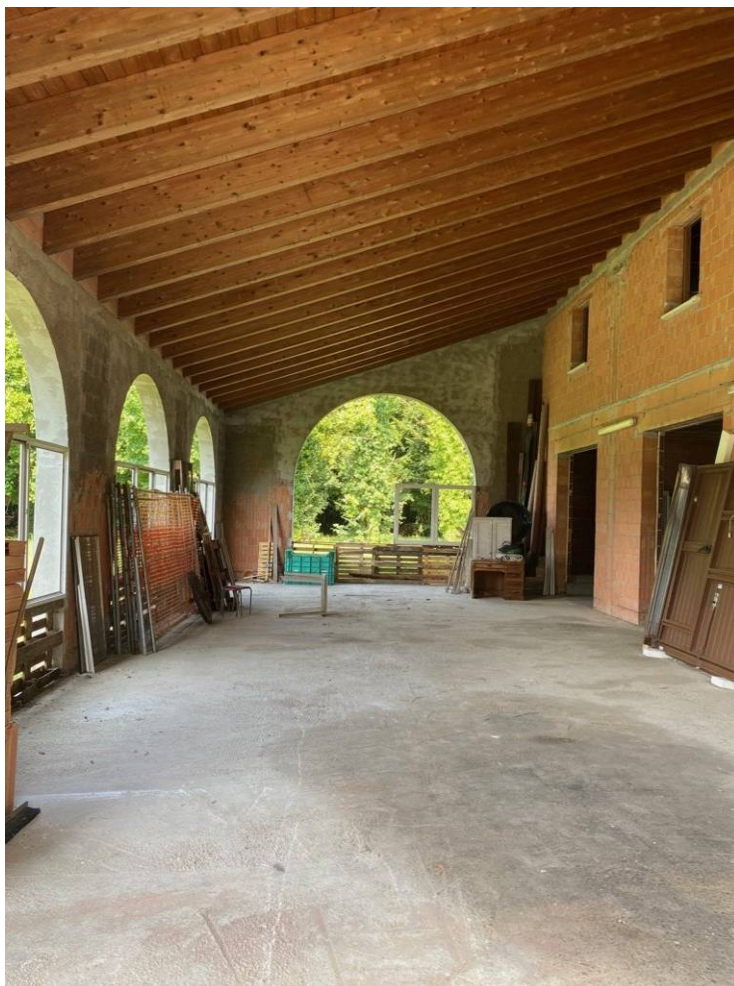
7- FOTO NUM.7, VISTA INTERNA PORTICATO LATO OVEST
