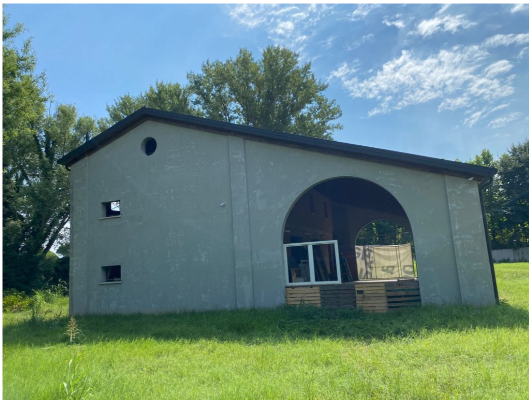
3- -FOTO NUM.3, VISTA ESTERNA LATO OVEST FABBRICATO
