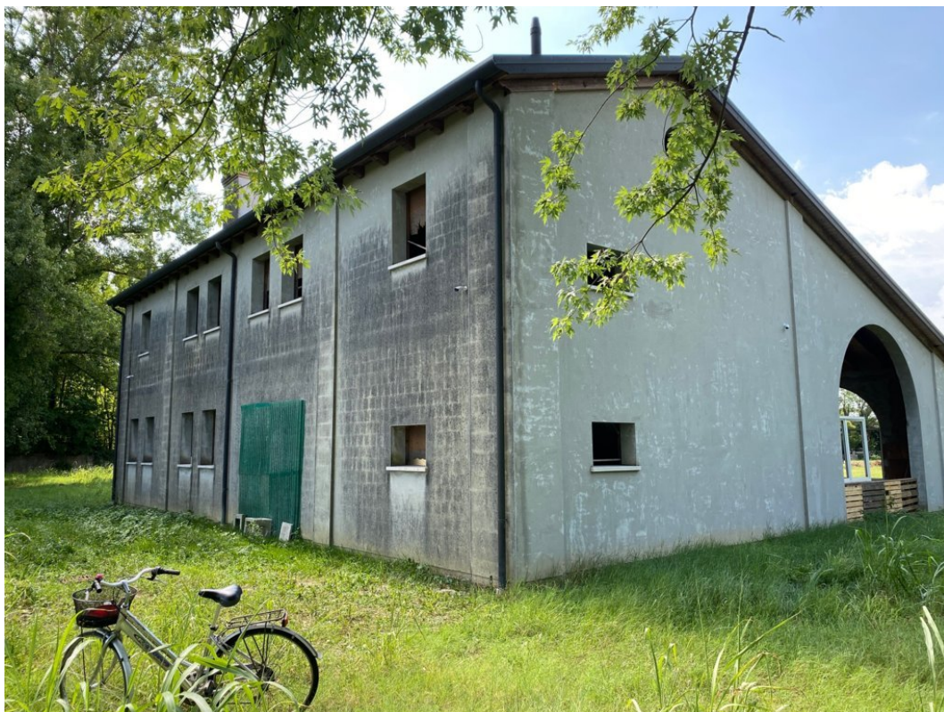
4- -FOTO NUM.4, VISTA ESTERNA LATO NORD/OVEST FABBRICATO
