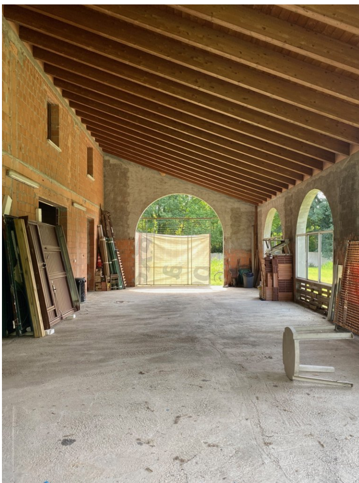
8- FOTO NUM.8, VISTA INTERNA PORTICATO LATO EST
