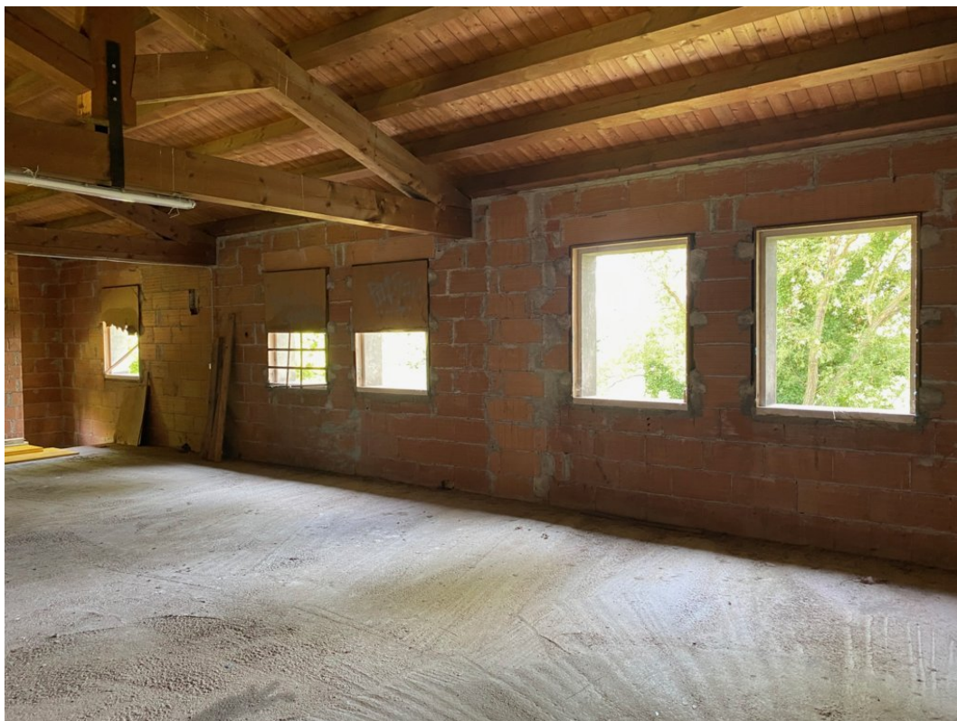
12- FOTO NUM.12, VISTA INTERNA DEPOSITO PIANO PRIMO
