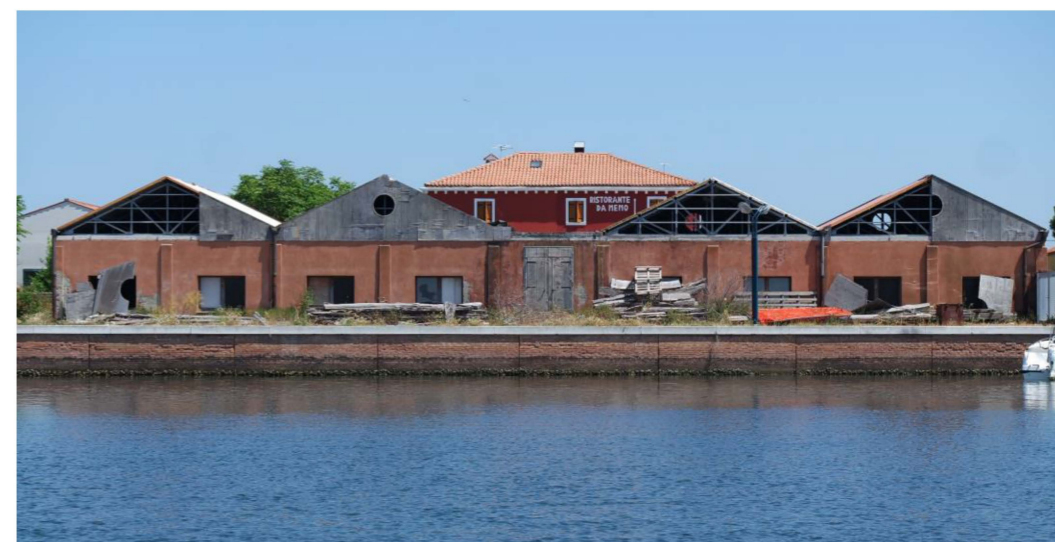
Stato di fatto fronte ovest
