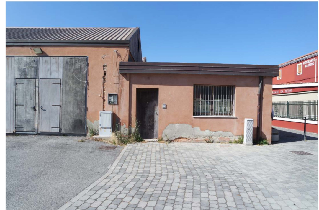
Porzione del fronte sud (previsto in demolizione)
