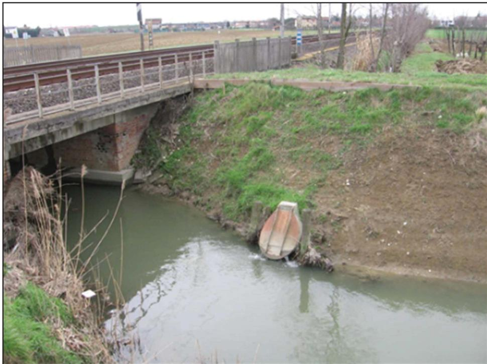
*Cono ottico 2* Scarico in Fossa Storta provvisto di clapet del fosso presente lungo il perimetro est del P. di L.
