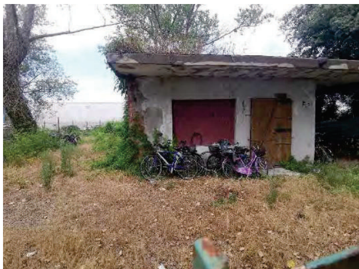
foto dell'area comunale oggetto di permuta (mappale 1008)
